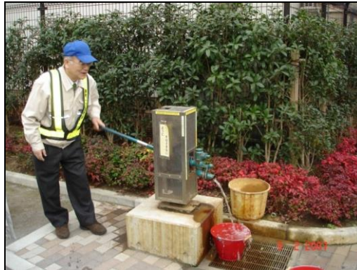
شکل ۴: نمونه پمپ دستی استحصال آب از مخازن زیرزمینی کم عمق برای استفاده در مواقع بحران
