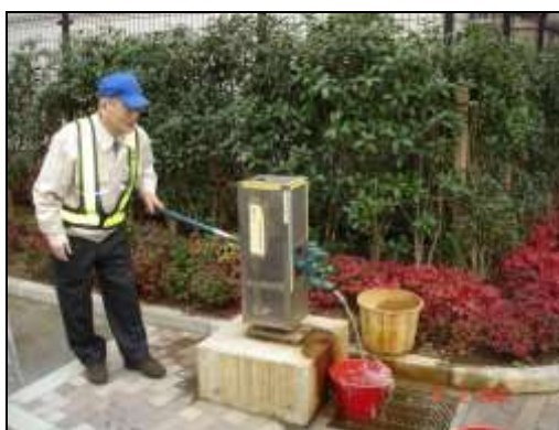
شکل ۴: نمونه پمپ دستی استحصال آب از مخازن زیرزمینی کم عمق برای استفاده در مواقع بحران
