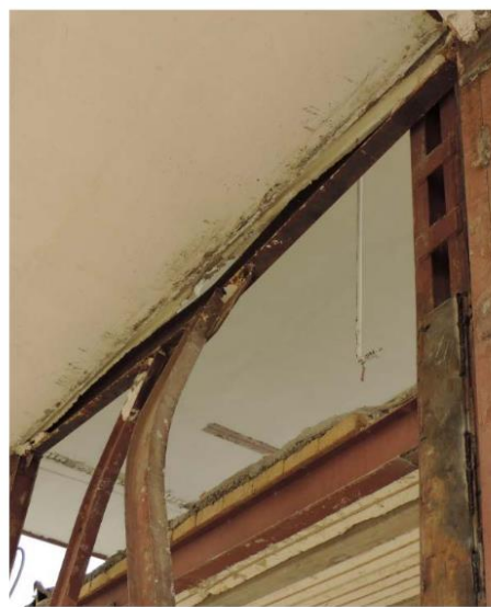
شکل (۴-۲۰): کماتش مهاربند در سیستم مهاربندی واگرا
