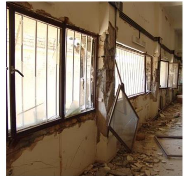
شکل (۵-۵): شکل‌گیری رفتار ستون کوتاه به علت کاهش طول آزاد در ستون بتن مسلح
