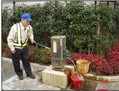
شکل ۴: پمپ دستی استحصال آب از مخازن زیرزمینی کم عمق برای استفاده در مواقع بحران
