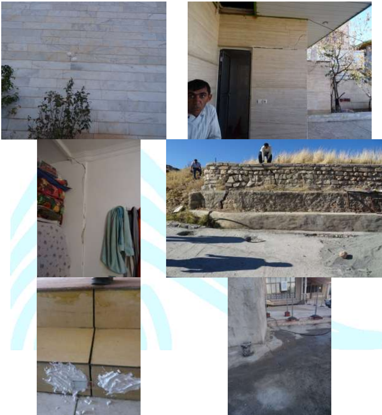
شکل ۳-۵۰- تصاویری از آسیب های سازه ای و ترک های ایجاد شده در مجتمع گردشگری نشمیل که در فراز تپه مشرف به شهر ساخته شده است.
