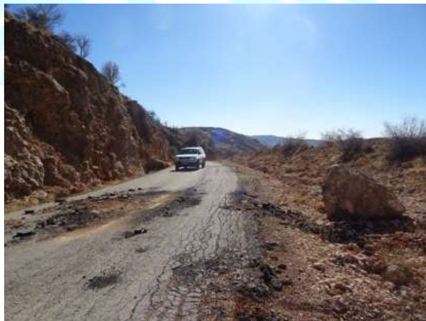
شکل ۳-۳۶- ریزش سنگی روی داده در مسیر فلات دالاهو
