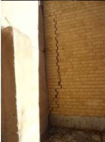
شکل ۳-۵۳- تصاویری از آسیب‌های سازه‌ای در اداره منابع طبیعی ردیف بالا و اداره برق دو ردیف پایین
