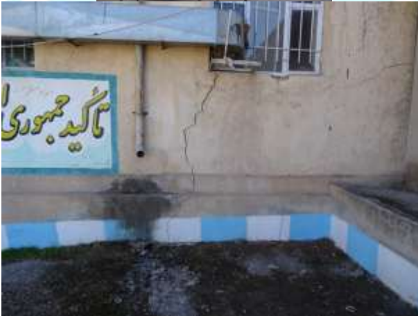
شکل ۳-۵۴- تصاویری از ترکهای زمین و آسیبهای سازه‌ای در اداره برق (دو ردیف بالا) و اداره جهاد-کشاورزی (پایین)
