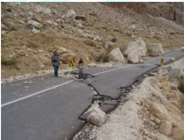
شکل ۳-۲۹- ریزش‌ها و بهمن سنگی در مسیر جاده آبشار پیران
