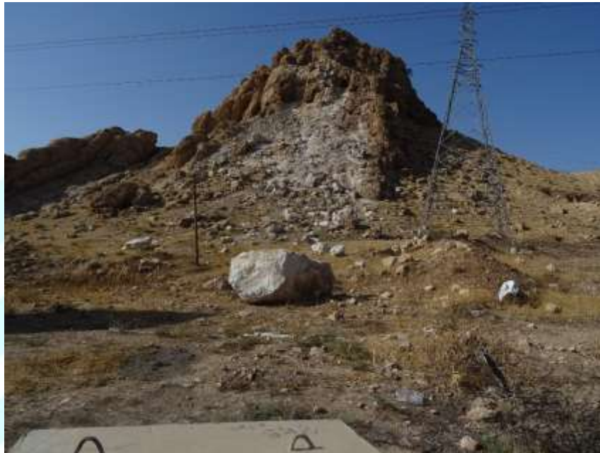
شکل ۳-۳۵- ریزش سنگی روی داده در مسیر گردنه پاتاق که منجر به سقوط دکل برق فشار قوی و مسدود شدن جاده اصلی کرمانشاه - سرپل ذهاب گردید
