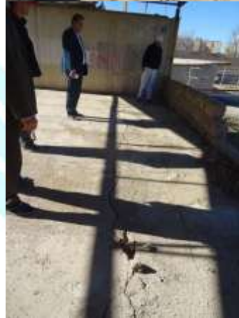
شکل ۳-۵۴- تصاویری از ترکهای زمین و آسیبهای سازه‌ای در اداره برق (دو ردیف بالا) و اداره جهاد-کشاورزی (پایین)
