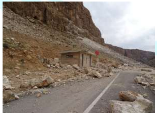
شکل ۳-۲۹- ریزش‌ها و بهمن سنگی در مسیر جاده آبشار پیران
