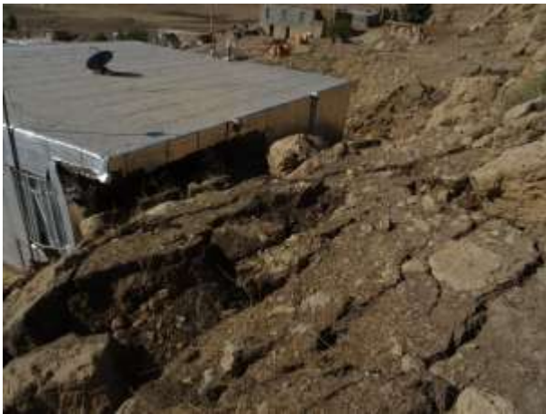
شکل ۳-۶- تخریب و مدفون شدن جاده قبرستان روستای قورچی باشی (راست) و تخریب خانه مسکونی در این روستا ناشی در محل پنجه زمین لغزش مله کبود- قورچی باشی
