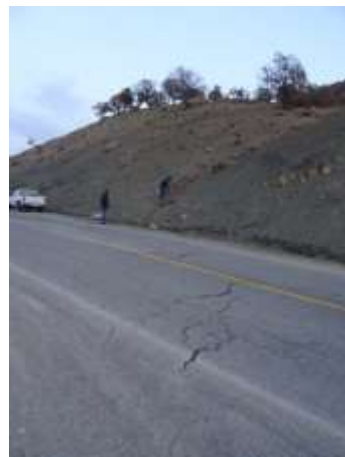
شکل ۳-۱۲- نمونه‌هایی از شکاف‌های ایجاد شده در بستر جاده در پهنه لغزشی شمال دالاهو
