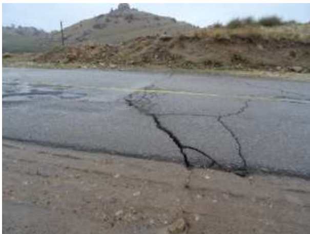
شکل ۳-۱۲- نمونه‌هایی از شکاف‌های ایجاد شده در بستر جاده در پهنه لغزشی شمال دالاهو
