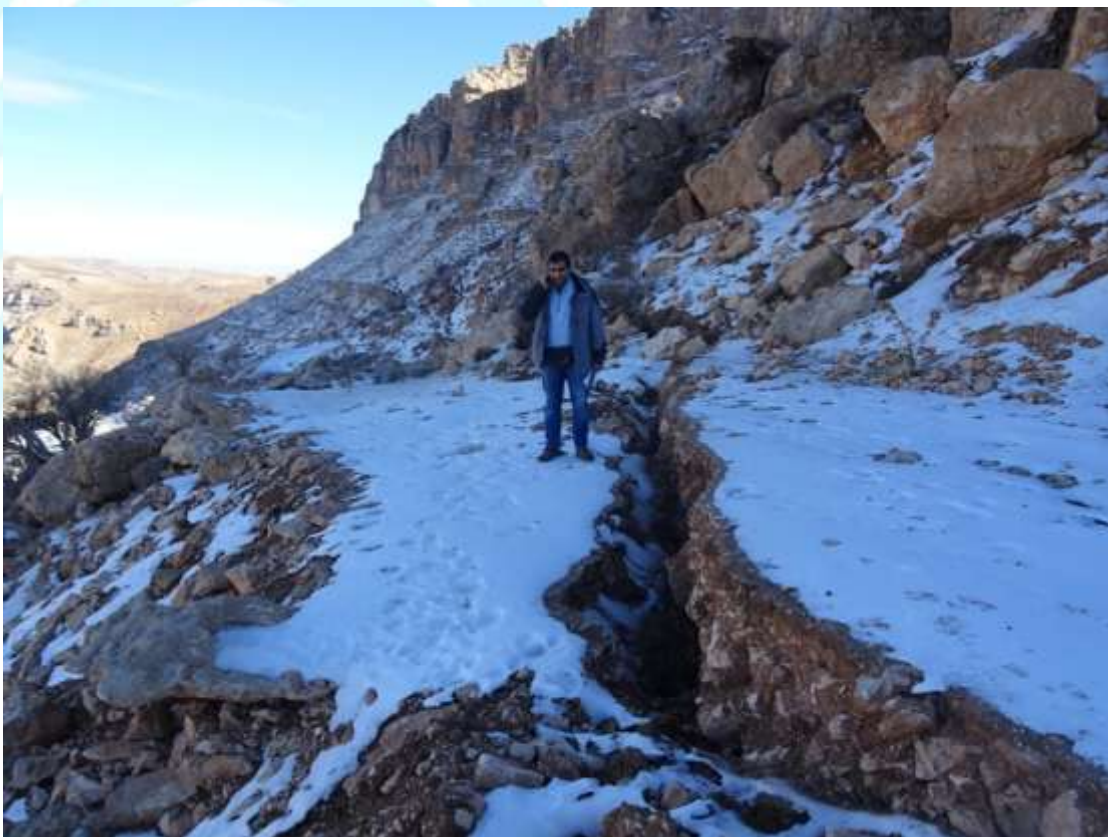
شکل ۳-۱۶- نمایی از تراس‌های ایجاد شده در اثر کلان لغزش قدیمی (بالا) و شکاف ایجاد شده در پای افراز اصلی آن در زمین- لرزه اخیر
