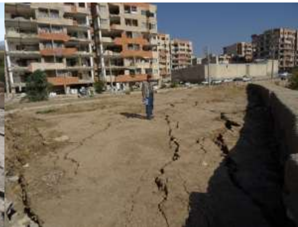
شکل ۲-۹- تصاویری از شکاف‌های ایجاد شده در اثر پدیده گسترش جانبی در محدوده مجتمع مسکن مهر شهید شیروودی
