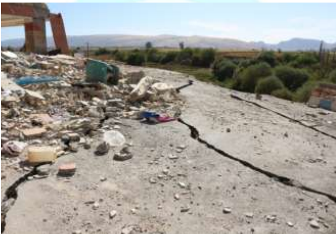
شکل ۲-۹- تصاویری از شکاف‌های ایجاد شده در اثر پدیده گسترش جانبی در محدوده مجتمع مسکن مهر شهید شیروودی
