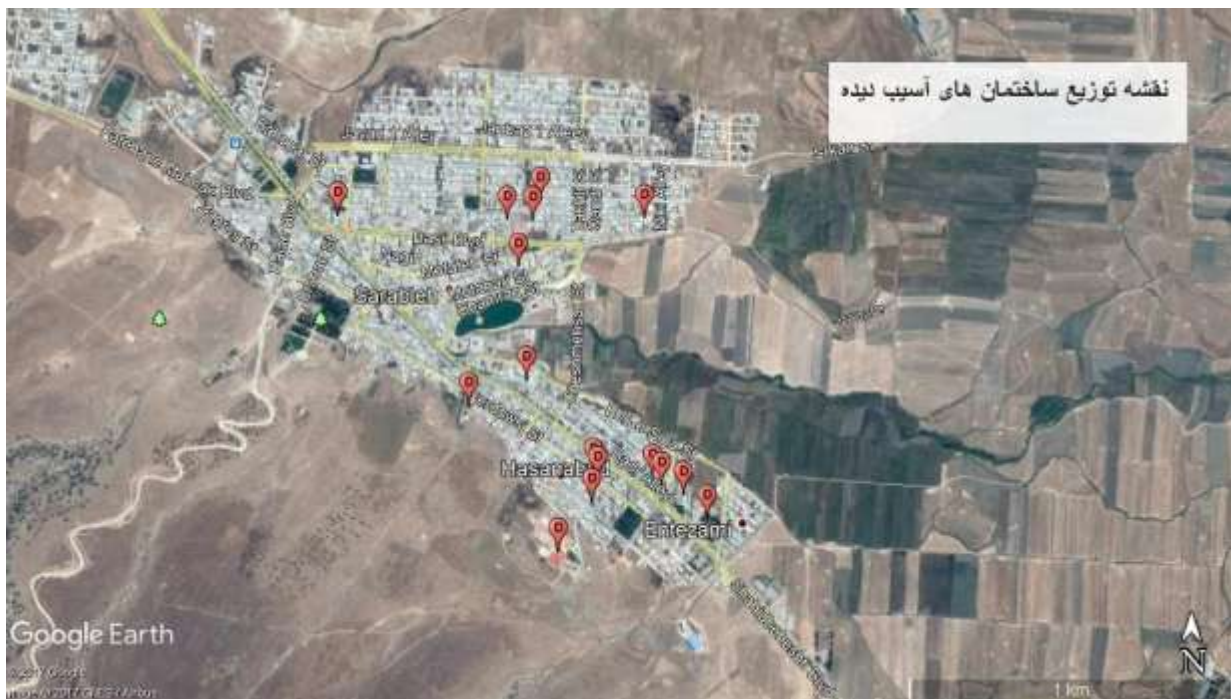
شکل ۳-۵۲- نقشه توزیع ساختمان‌های آسیب دیده بازدید شده تا تاریخ ۲۸ آذر ۱۳۹۶. ساختمان‌های دیگری نیز آسیب دیده‌اند که بازدید نشده‌اند.
