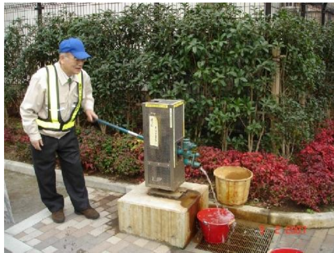
شکل ۴: پمپ دستی استخراج آب از مخازن زیرزمینی کم عمق برای استفاده در مواقع بحران
