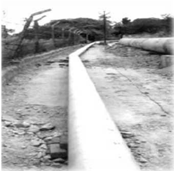
شکل (۱): عدم مهاری لوله.
