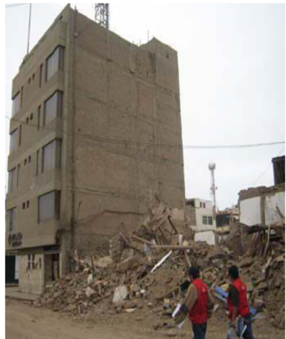
شکل (۲): عملکرد ساختمان‌های آجری کلاف‌دار در زلزله سال ۲۰۰۷ پرو، ساختمان شش طبقه بدون آسیب.
