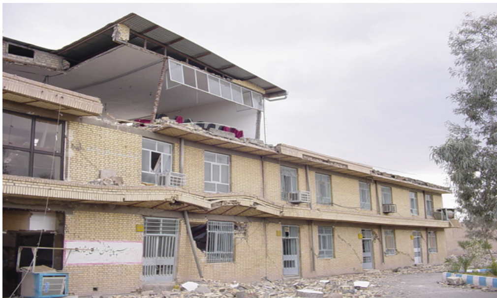
شکل (۳): آسیب‌دیدگی یک ساختمان آجری کلاف‌دار (دانشکده علوم پزشکی جوادالائمه) در زلزله‌ی ۲۰۰۳ بزم [۵].
