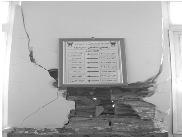
شکل (29): نمونه‌ای از آسیب‌های وارده به تیغه بین دو بازشو.
