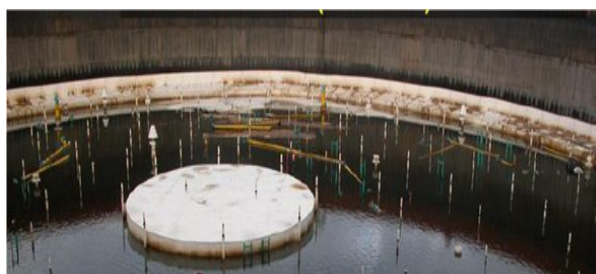
شکل (7): پخش شدن مایع و نفوذ آن بر روی سقف شناور مخزن نفت [4].
