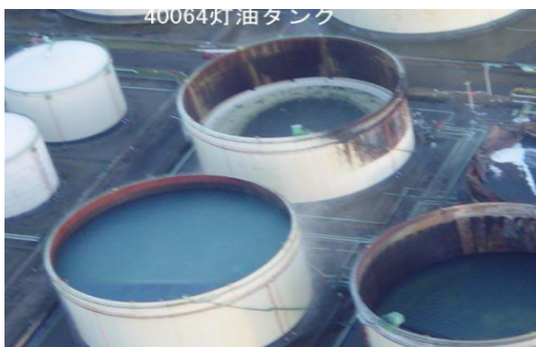
شکل (8): غرق شدن سقف شناور و فرو رفتن آن بعد از زلزله توکاشی-اوکی [4].
