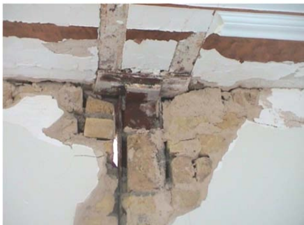
شکل (۲): نمونه‌هایی از گسیختگی اتصال مفصلی در زلزله‌های گذشته (آرشیو پژوهشگاه).
