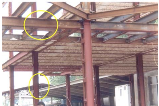
شکل (۱): نمونه‌هایی از اجرای اتصال نشیمن ساده در ساختمانهای اسکلت فولادی (آرشیو پژوهشگاه).
