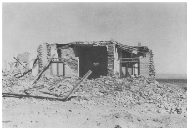
شکل (۹): تخریب درمانگاهی در دانشفهان در اثر زلزله [۴].
