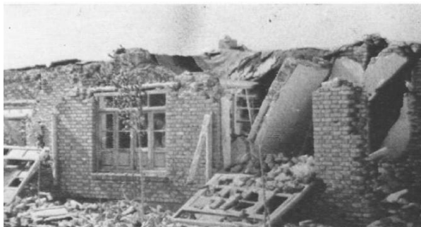
شکل (۷): تخریب ساختمانی در بوئین‌زهر در اثر زلزله سال ۱۳۴۱/۴.
