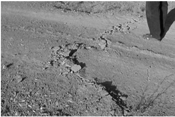
شکل (۱۷): گسیختگی سطحی زمین‌لرزه چنگوره آوج در شمال چنگوره - کیلومتر ۳ جاده چنگوره-آبدره.
