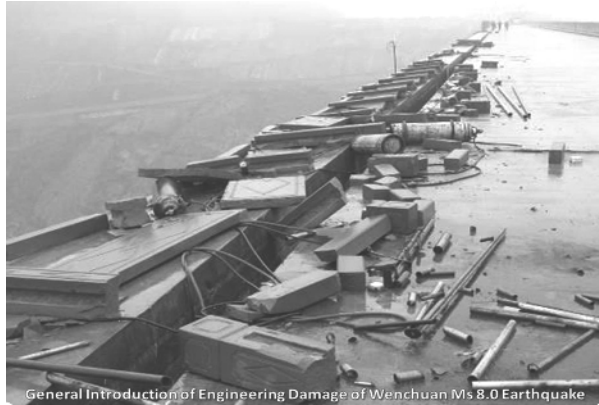
تصویر (۳): قسمت فوقانی سد زی‌پینگ‌پو، ترک برداشته و گاردریلها ویران شده‌اند.
