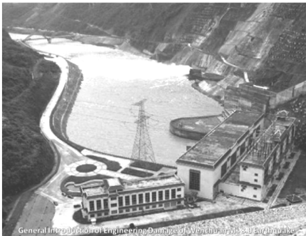
تصویر (۴): کارگاه و ساختمانهای سالم مانده سد زی‌پینگ‌پو.
