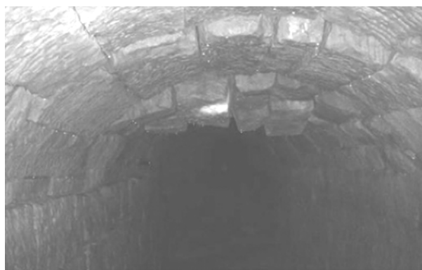
تصویر (۱۴): خسارت وارده به سقف تونل سرریز مخزن ون‌جیاجیو در شهرستان کانگشی.
