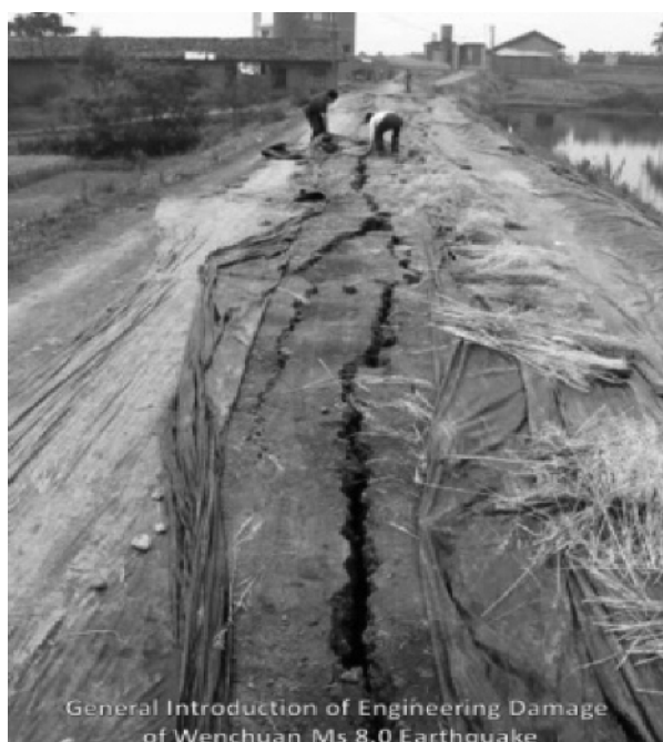
تصویر (۱۱): ترکهای طولی در مخزن سد خاکی داسونگ‌شو.
