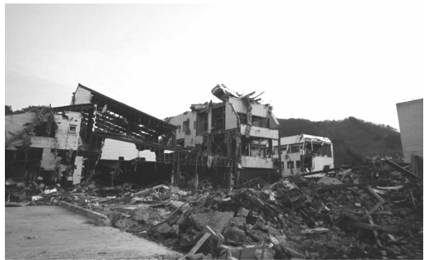
تصویر (۲): خرابی ایجاد شده در شهر اوناگاوا (Onagawa).
