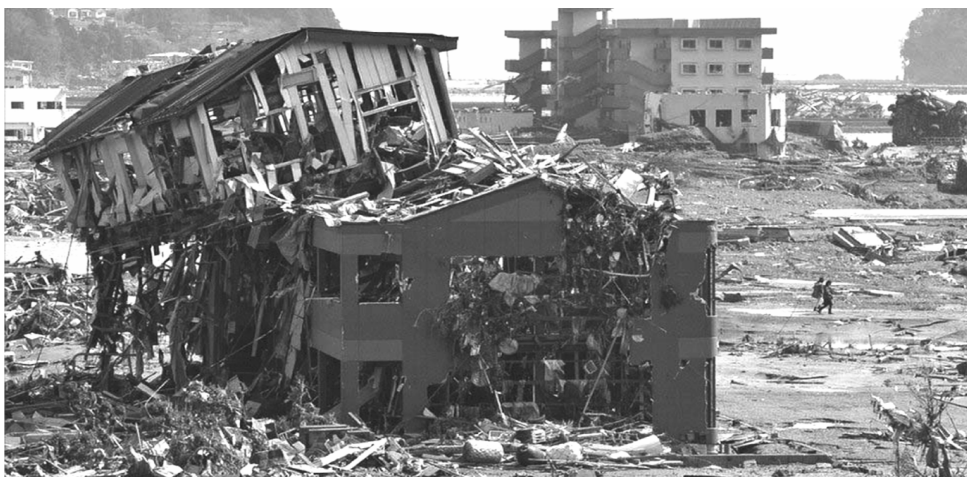
تصویر (۴): تخریب ساختمان چوبی در زلزله ژاپن.
