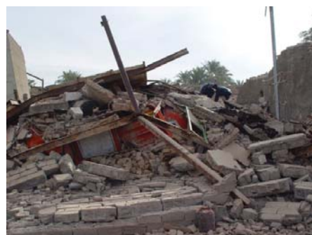
شکل (۱): تخریب ایستگاه آتش‌نشانی شهر بم در اثر زلزله
