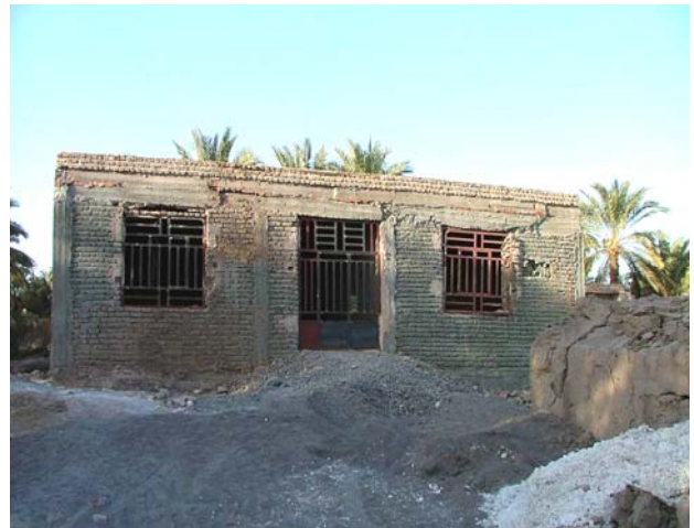
تصویر (۴): نمونه‌ای از ساختمان بنایی با کلاف بتن مسلح در بم
