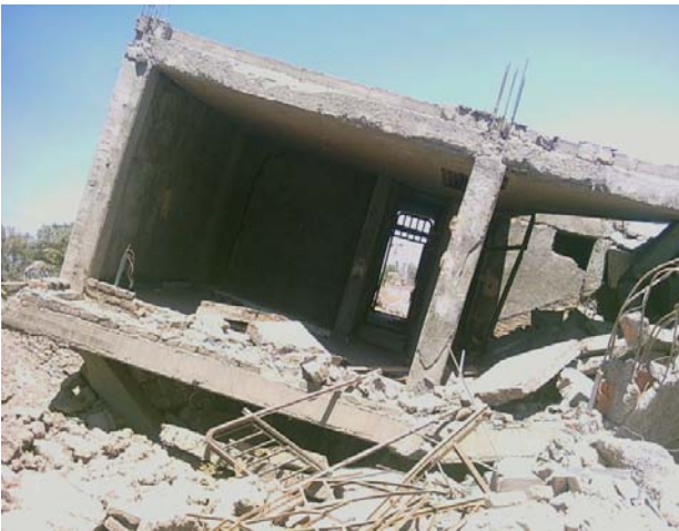
تصویر (۶): نمونه‌ای از ساختمان بتنی مسلح در شهر بم
