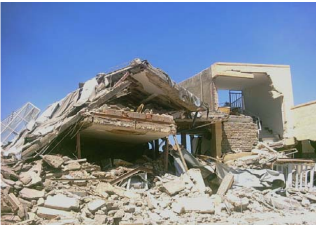
تصویر (۳): نمونه‌ای از ساختمان نیمه اسکلت فلزی در بم
