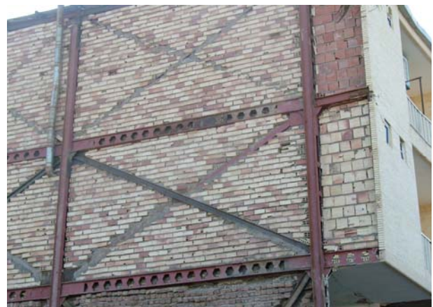
تصویر (۵): نمونه‌ای از ساختمان اسکلت فلزی در شهر بم
