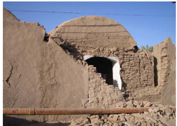
تصویر (۱): یک نمونه ساختمان خشتی-گلی در شهر بم
