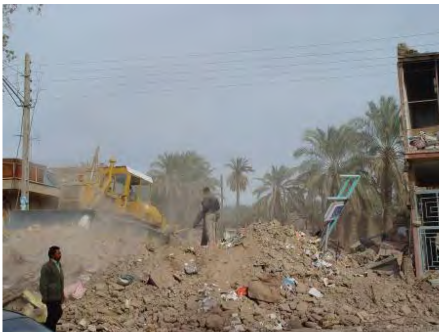
شکل (۸-۵): استفاده از ماشین آلات سنگین در عملیات جستجو و نجات در روز دوم زلزله
