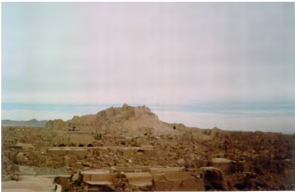
شکل (۷-۵): نمای بخش حاکم نشین پس از وقوع زلزله
