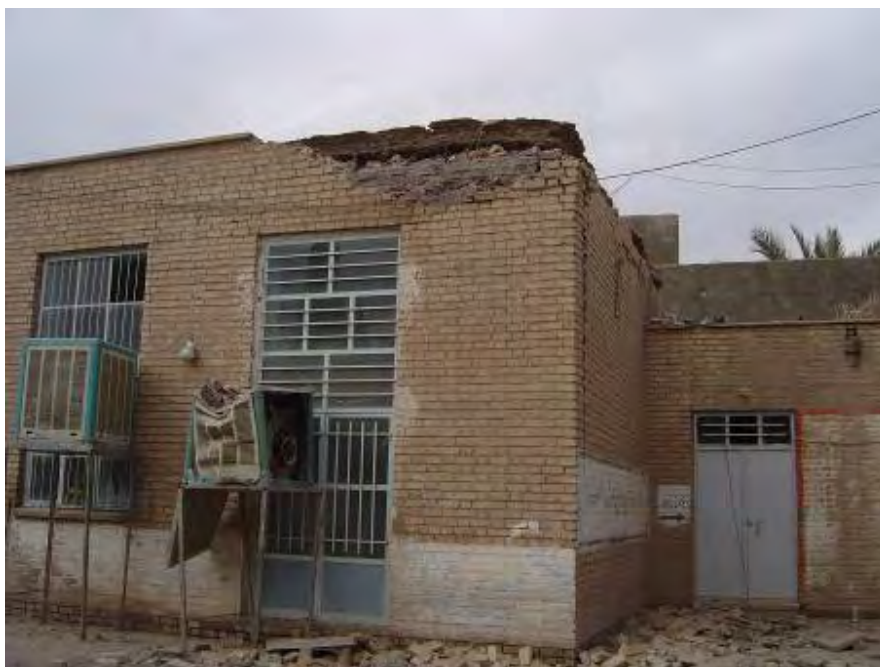
شکل (۴-۷۸-ب): خسارات وارد بر تأسیسات ساختمانیها
