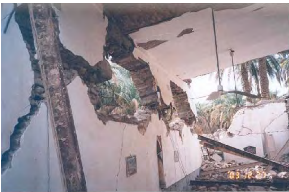
شکل (۴-۱۰): ترک ضربدری بین دوبازشو در یک دیوار آجری
