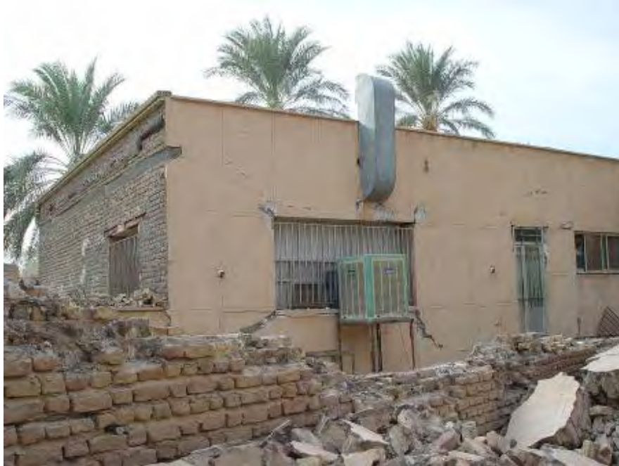
شکل (۴-۲۴-الف): عملکرد مناسب ساختمانهای مصالح بنایی که مطابق آئین نامه طراحی اجرا شده اند
