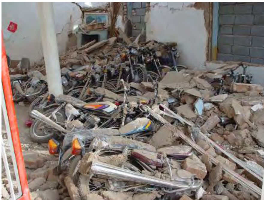
شکل (۴-۷۷-د): خسارات وارد بر تجهیزات و وسایل داخل ساختمان
