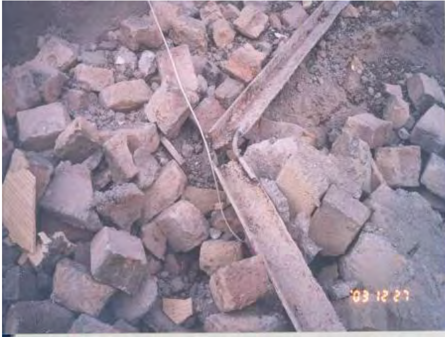
شکل (۴-۵۸): وصله یک بادبند نبشی با میل گرد
