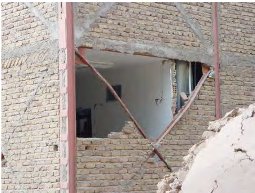
شکل (۴-۴۶-الف): کمانش بادبند متشکل از نبشی تک
