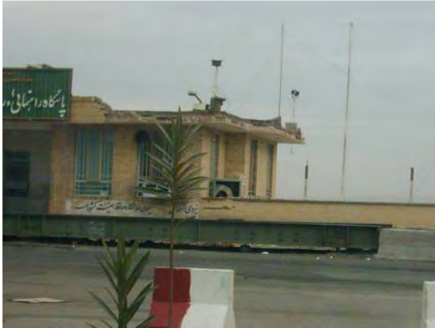
شکل (۴-۷۲-ج): خسارت در بالکن ها و فروریختن جان پناه بام و بالکن در ساختمانها
