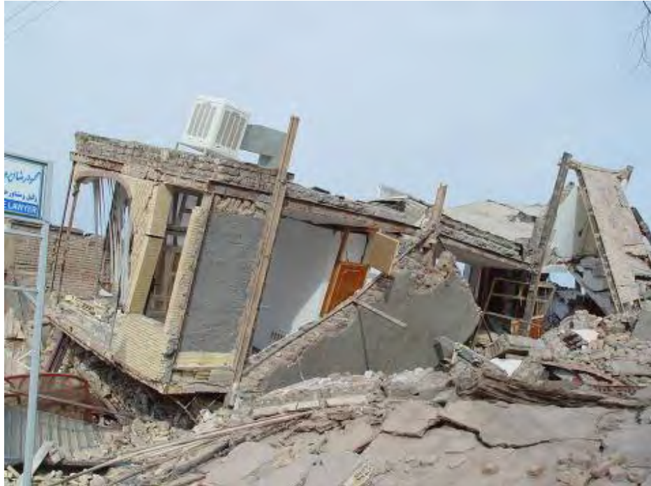
شکل (۴-۳۰-الف): ایجاد مکانیزم در اثر طبقه نرم در یک ساختمان فولادی
