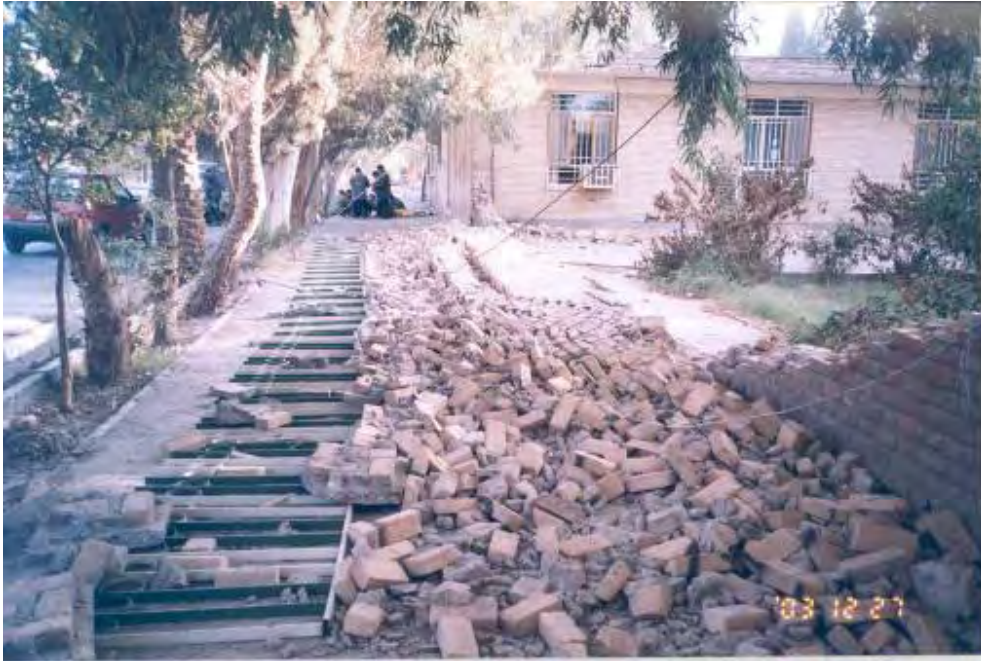
شکل (۴-۷۶-الف): خسارات وارد بر دیوارهای محوطه
