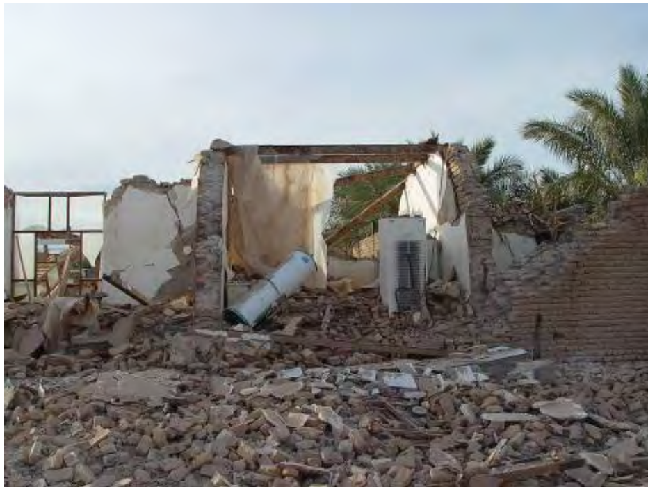
شکل (۴-۱۷-ب): فروریختن سقف ها و طاق های ضربی در ساختمانهای بنایی
