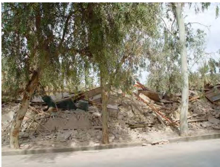
شکل (۴-۲۳-د): فروریختگی کلی در ساختمانهای مصالح بنایی
