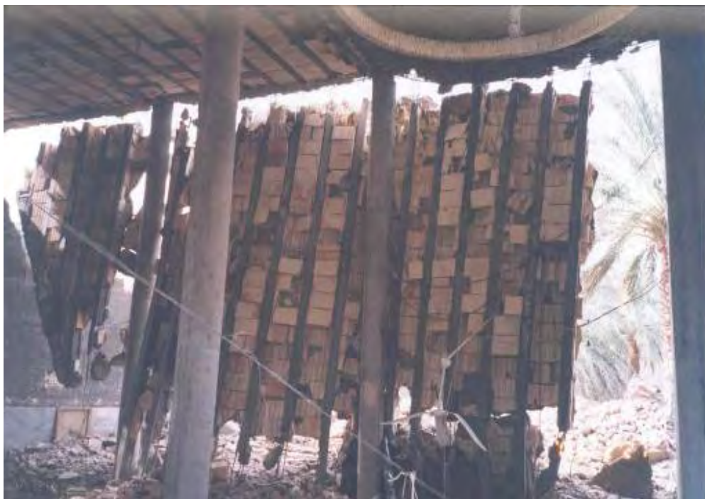
شکل (۴-۱۵): فروریختن کامل سقف در اثر تخریب دیوارهای باربر در یک ساختمان بنایی
