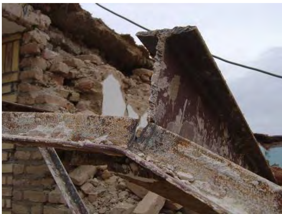
شکل (۴-۱۹-الف): اتصال تیرچه های سقف با نبشی در سقف یک ساختمان بنایی
