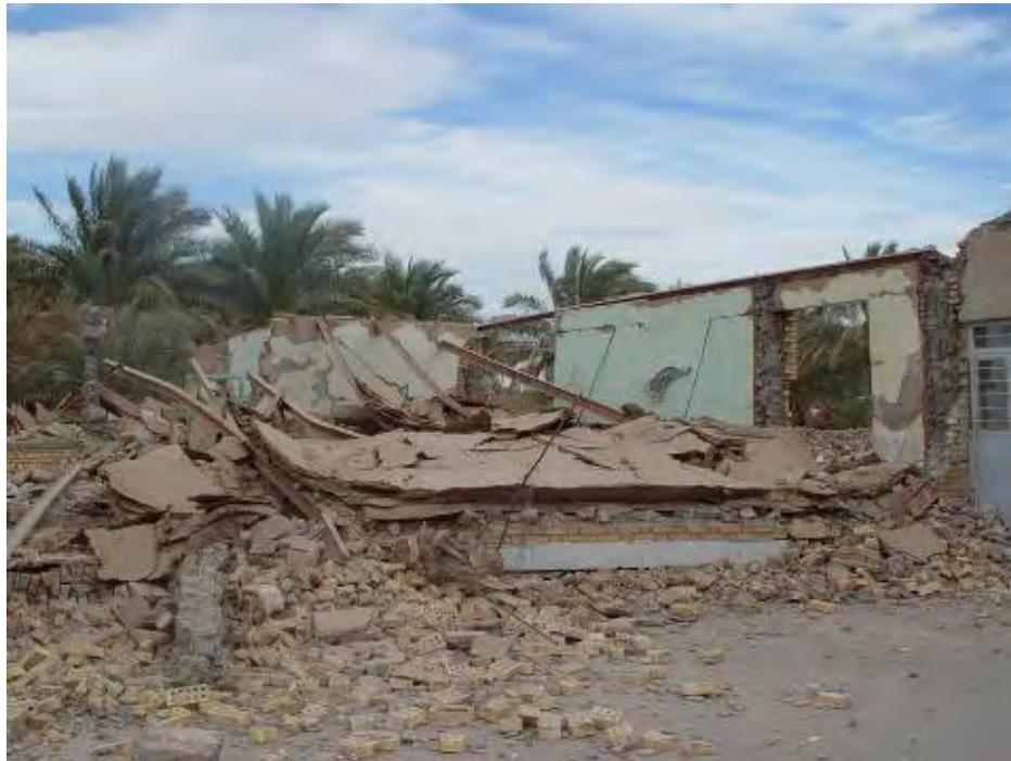
شکل (۴-۱۵): فروریختن کامل سقف در اثر تخریب دیوارهای باربر در یک ساختمان بنایی
