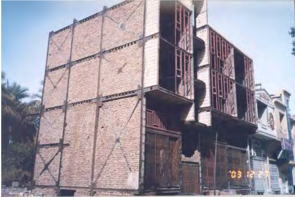
شکل (۴-۶۱-الف): عملکرد مناسب ساختمانهای فولادی دارای بادبند
