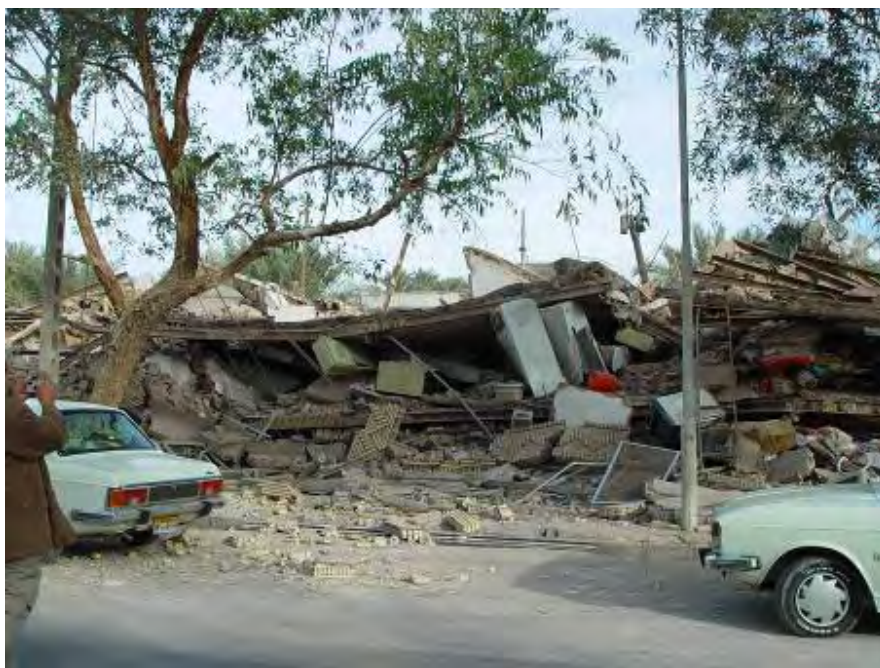
شکل (۴-۵۳): فرو ریختن سقف در یک ساختمان فولادی؛ به نقش یخچال در نگهداری سقف و ایجاد فضایی در زیر آن توجه شود
