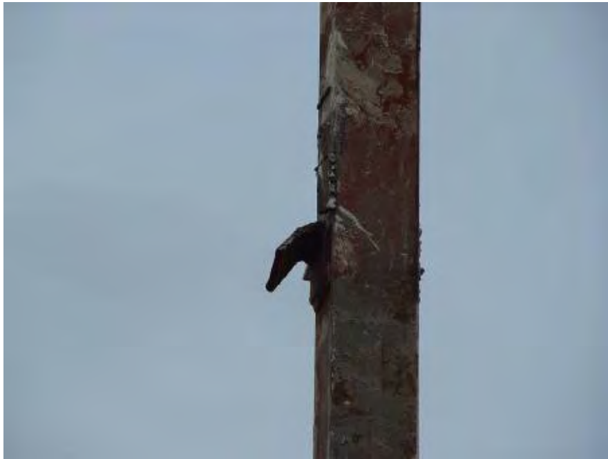
شکل (۴-۴۱): تغییر شکل خمشی در نبشی نشیمن
