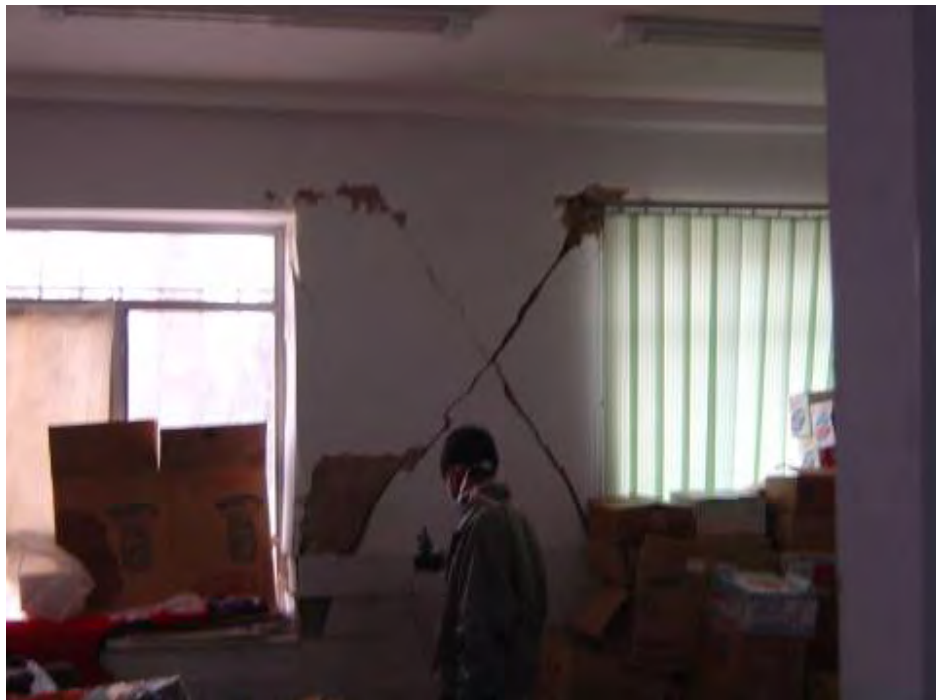
شکل (۴-۱۰): ترک ضربدری بین دوبازشو در یک دیوار آجری
