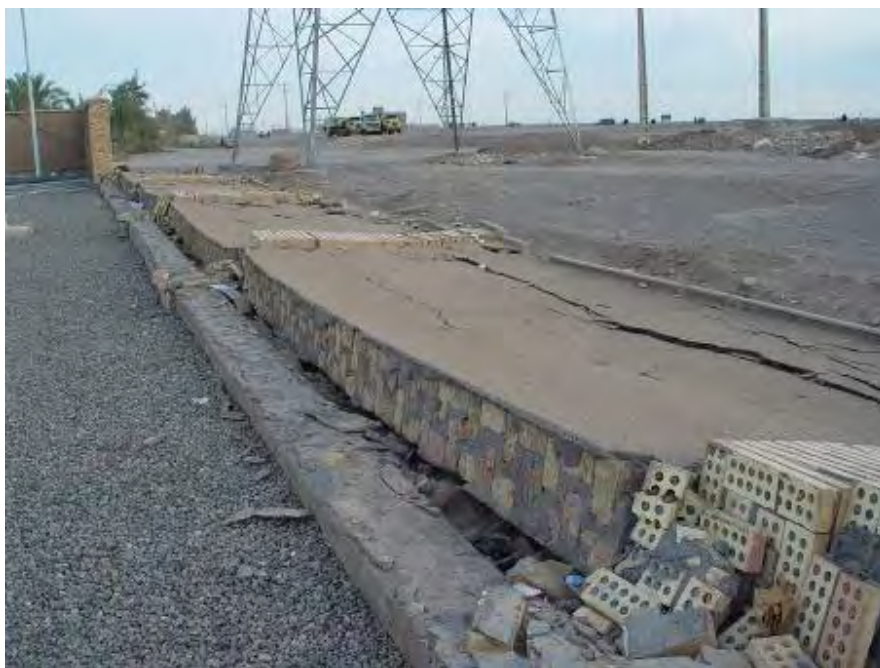
شکل (۴-۷۶-ج): خسارات وارد بر دیوارهای محوطه
