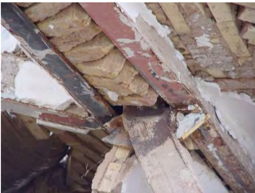
شکل (۴۰-۴): لهیدگی ستون قوطی شکل در اتصال خورجینی
