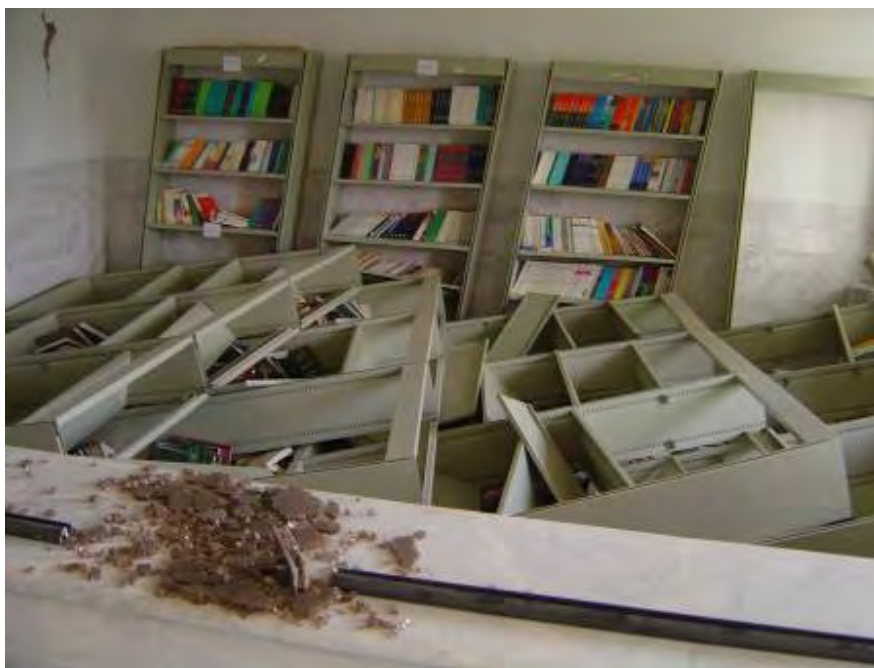
شکل (۴-۷۷-الف): خسارات وارد بر تجهیزات و وسایل داخل ساختمان
