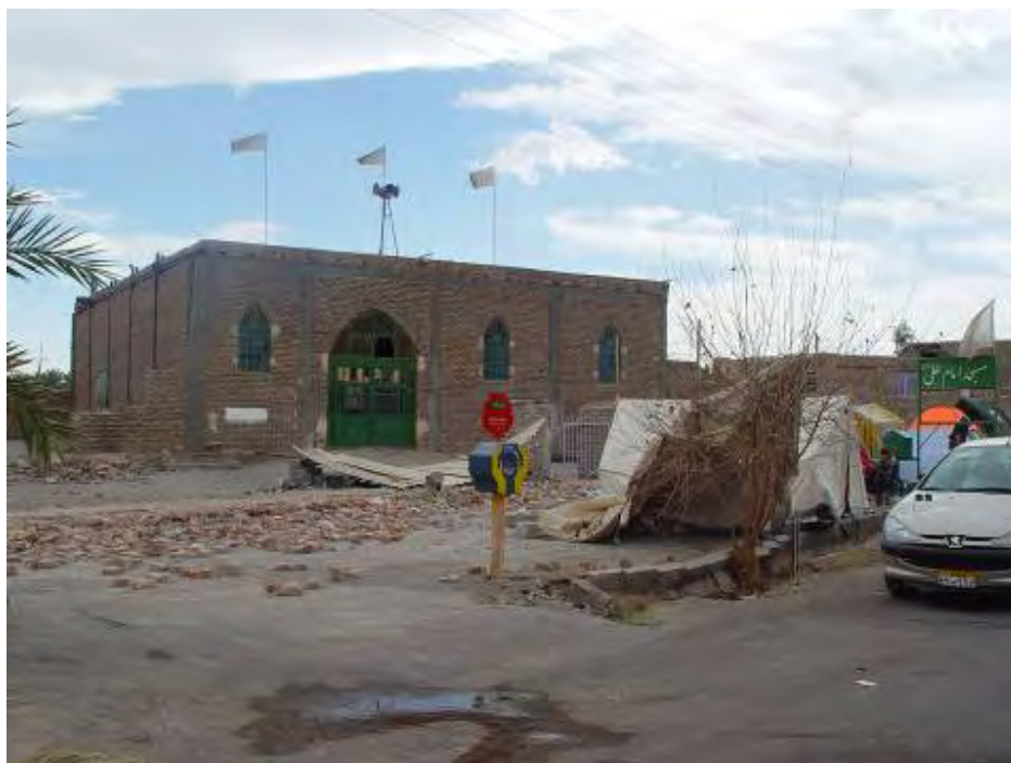
شکل (۴-۲۴-ج): عملکرد مناسب ساختمانهای مصالح بنایی که مطابق آئین نامه طراحی و اجرا شده اند
