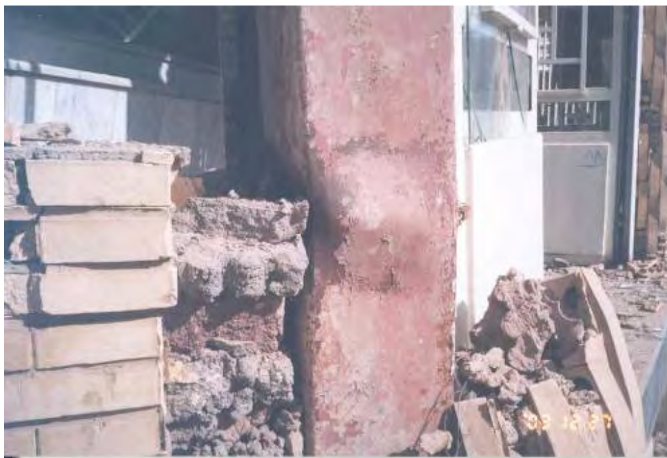
شکل (۴-۶۰): کمانش موضعی ورق جان پروفیل قوطی شکل در عملکرد ستون کوتاه
