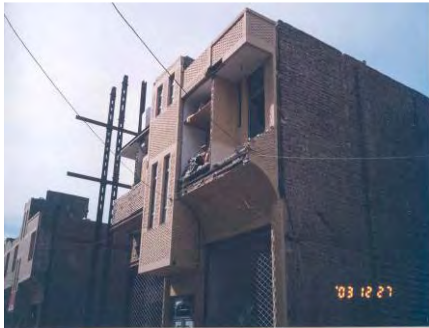
شکل (۴-۷۲-د): خسارت در بالکن ها و فروریختن جان پناه بام و بالکن در ساختمانها
