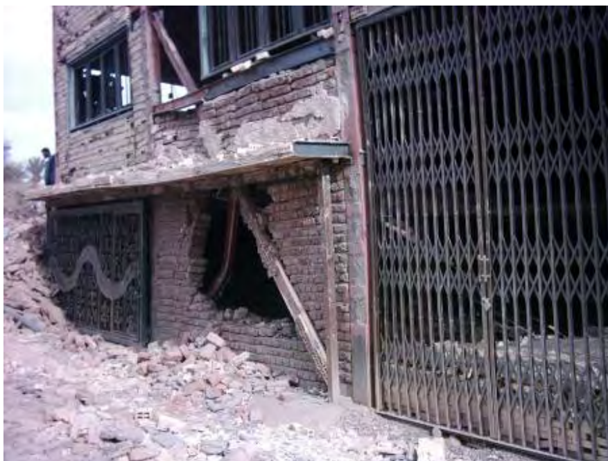
شکل (۴-۴۹): نمای دور از ساختمان شکل (۴-۴۸); به فرم بادبند توجه شود
