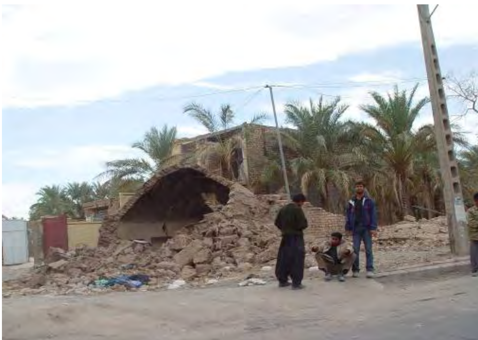
شکل (۴-۶): گسیختگی و فروریختگی جزئی در یک سقف گنبدی خشتی
