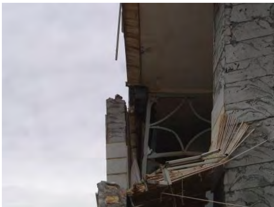
شکل (۴-۷۲-ب): خسارت در بالکن ها و فروریختن جان پناه بام و بالکن در ساختمانها
