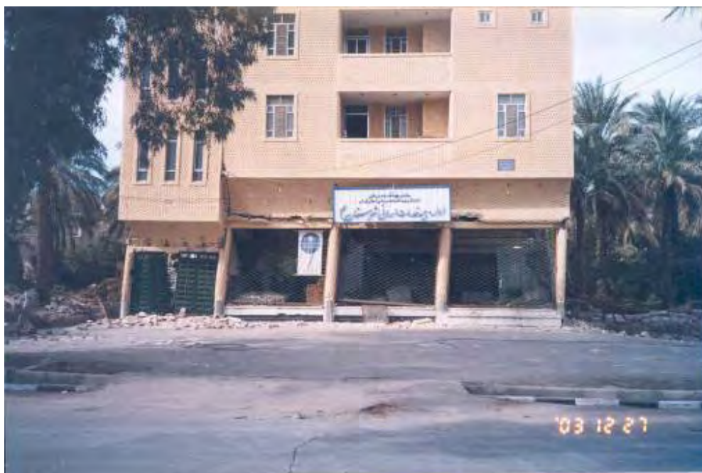
شکل (۴-۳۲): طبقه نرم و تغییر مکان جانبی در یک ستون مشبک
