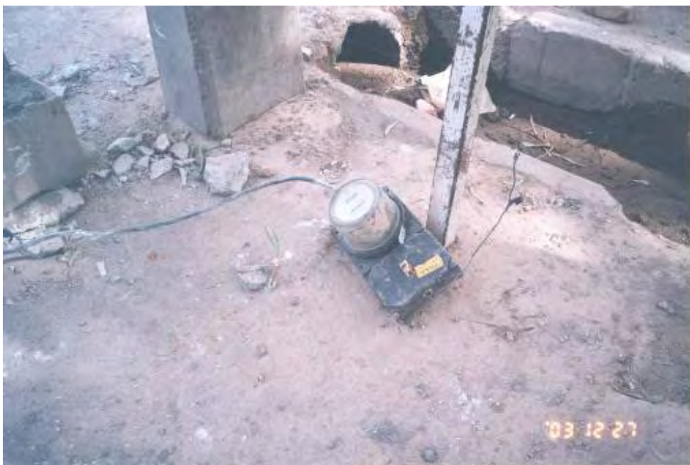
شکل (۴-۷۷-الف): خسارات وارد بر تجهیزات و وسایل داخل ساختمان
