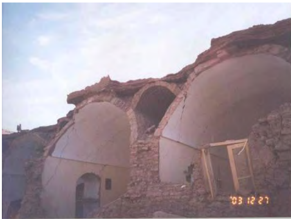
شکل (۴-۲): فروریختگی خارج از صفحه دیوار در یک ساختمان خشتی
