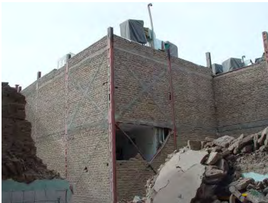
شکل (۴-۴۶-ب): کمانش بادبند متشکل از نبشی تک
