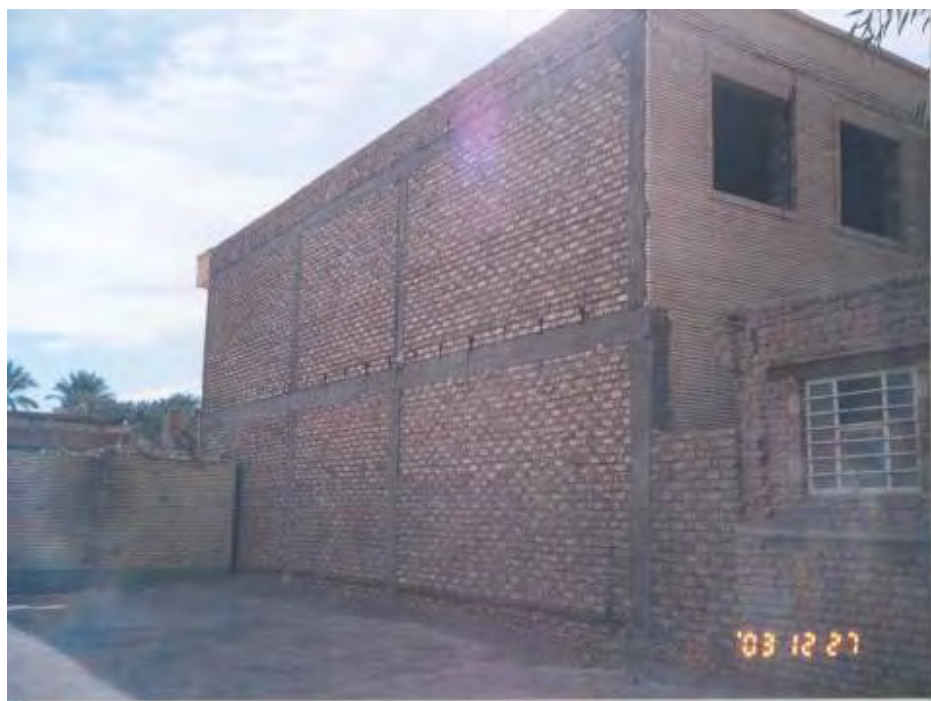
شکل (۴-۲۴-د): عملکرد مناسب ساختمانهای مصالح بنایی که مطابق آئین نامه طراحی و اجرا شده اند
