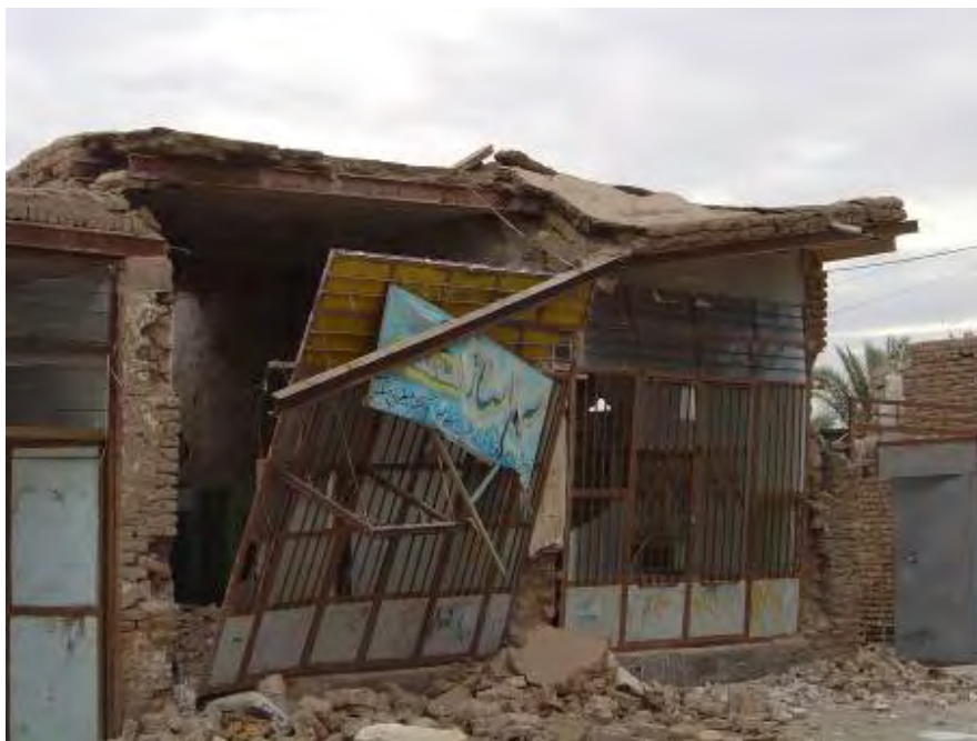
شکل (۴-۷۳-ب): خسارت در و پنجره ها و فروریختن آنها
