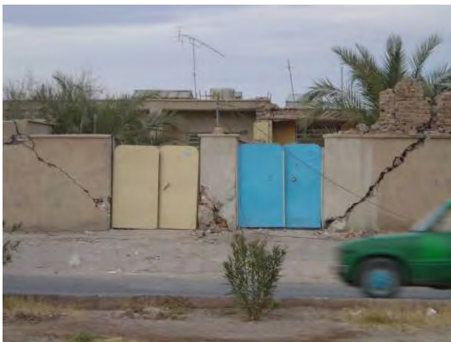
شکل (۴-۷۶-د): خسارات وارد بر دیوارهای محوطه
