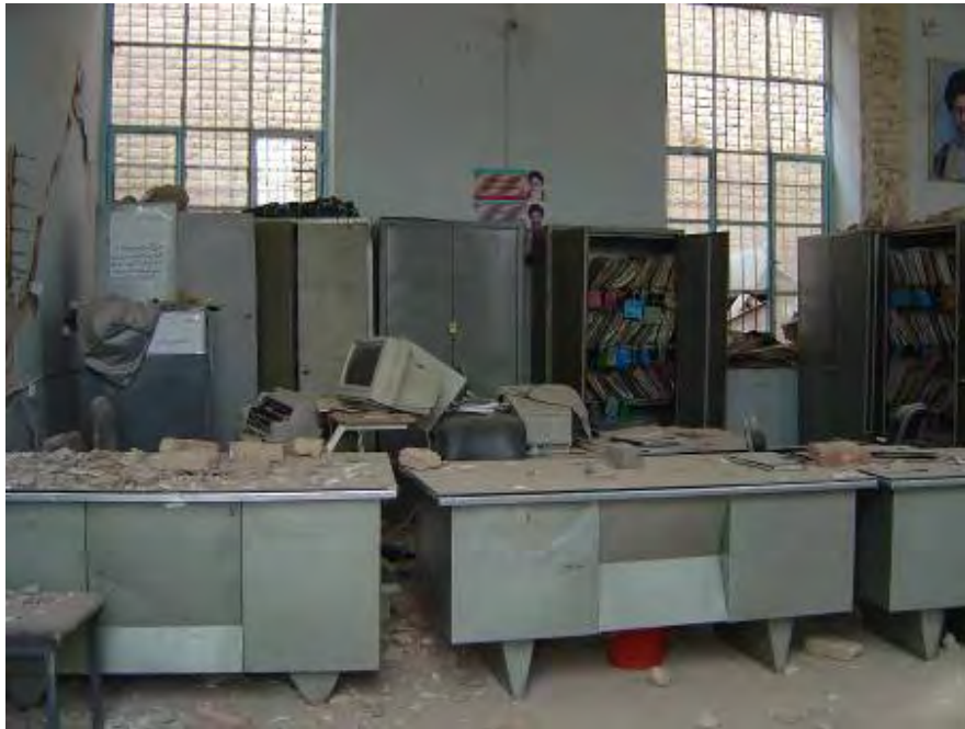
شکل (۴-۷۷-ج): خسارات وارد بر تجهیزات و وسایل داخل ساختمان
