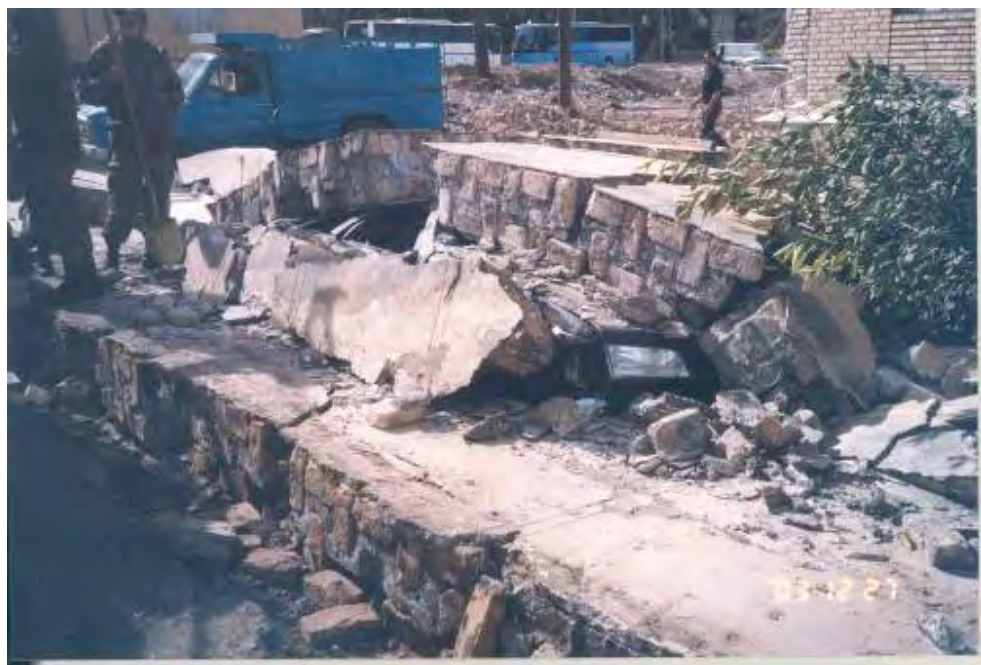
شکل (۴-۷۶-ب): خسارات وارد بر دیوارهای محوطه
