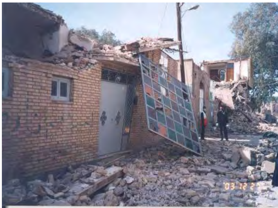
شکل (۴-۷۳-الف): خسارت در و پنجره ها و فروریختن آنها
