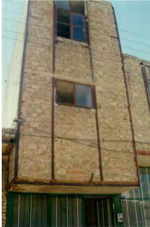
شکل (۴-۷۹-الف): عملکرد مناسب مهارهای قائم در نگهداری دیوارهای غیرسازه ای به طور نسبی
