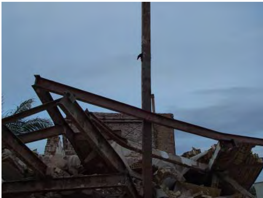
شکل (۴-۴۲): جداسدن تیرها از اتصالات
