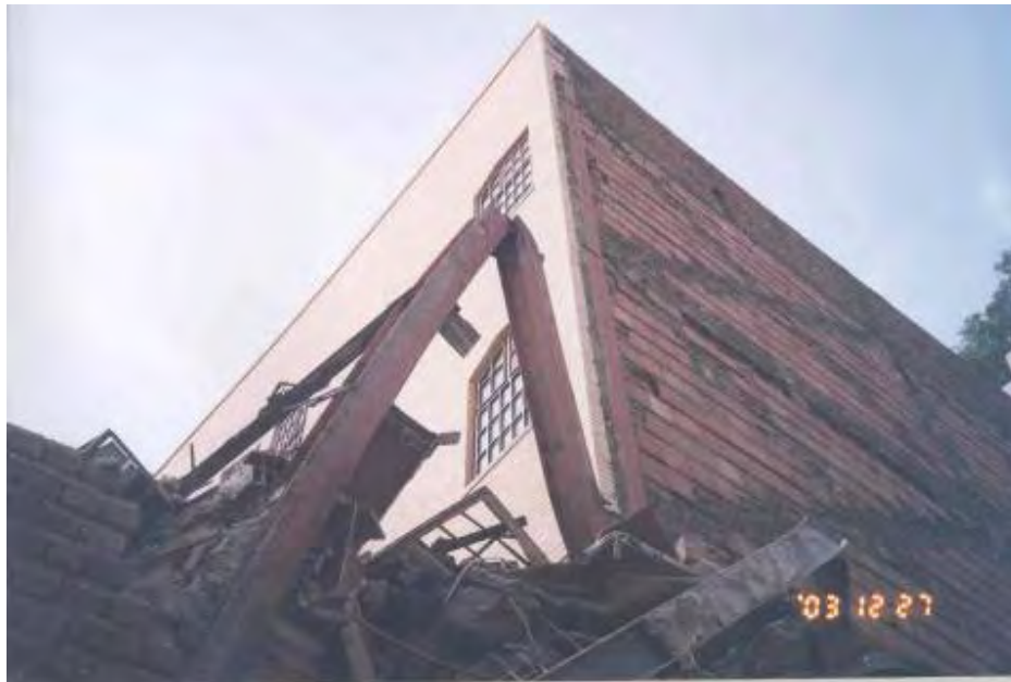
شکل (۴-۴۴-ج): خسارت شدید و فروریختگی در یک ساختمان ۵ طبقه فولادی؛ شکست ستون در محل اتصال
