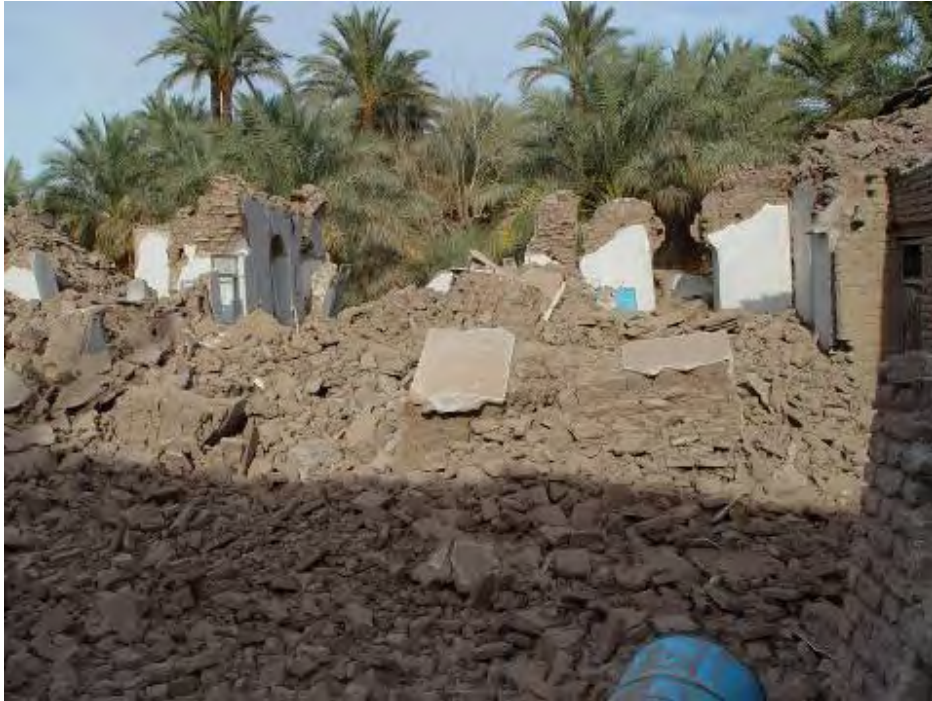
شکل (۷-۴): فروریختگی کلی در ساختمانهای خشتی
