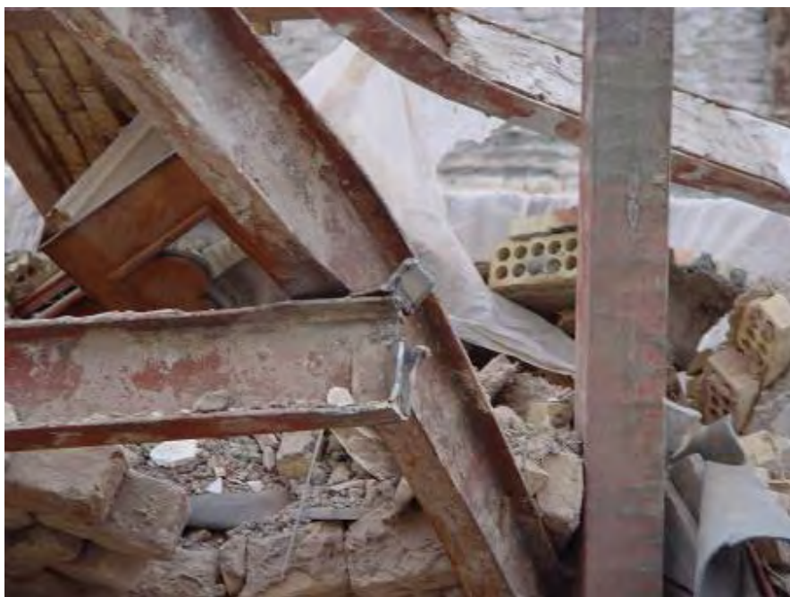
شکل (۴-۴۳): جدا شدن نبشی های جان و نگهدارنده فوقانی در یک اتصال ساده
