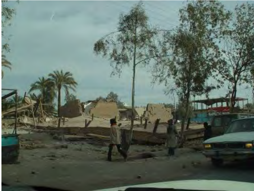
شکل (۴-۵۱): شکست ستونها و فروریختن سقف در یک ساختمان فولادی
