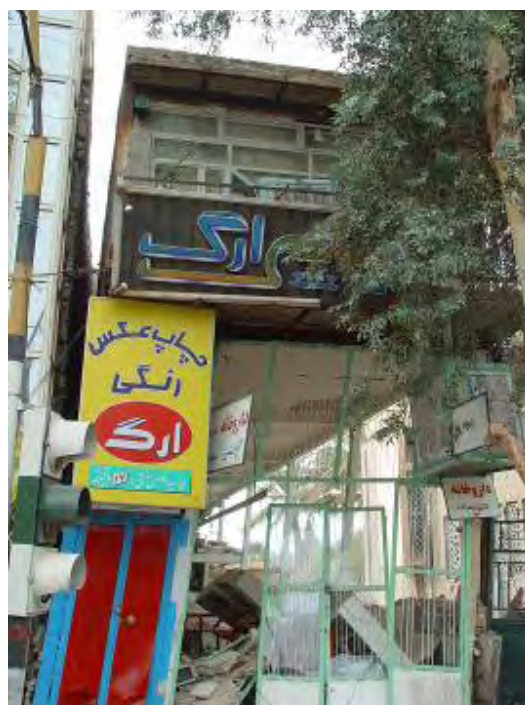
شکل (۴-۲۸): طبقه نرم و تغییر مکان افقی در یک ساختمان فولادی
