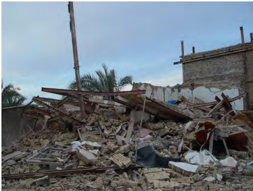
شکل (۴-۳۸): فروریختگی کلی در یک ساختمان فولادی بدون بادبند
