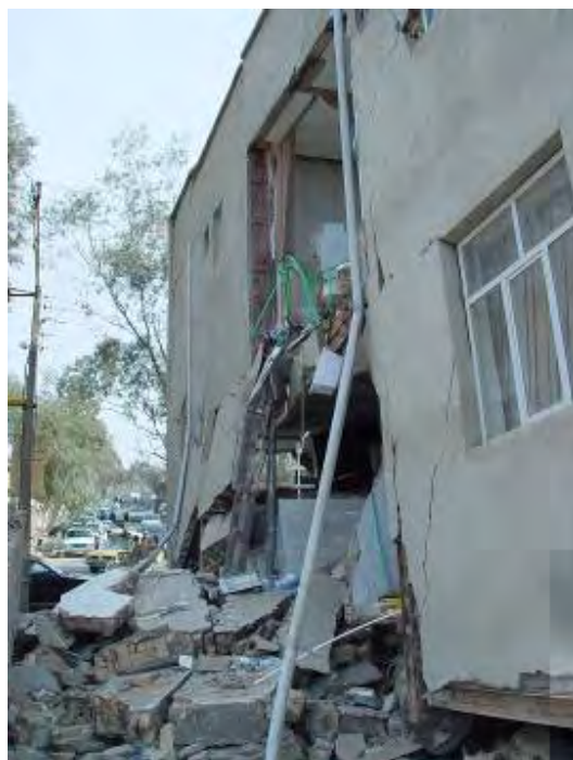
شکل (۴-۳۵): ایجاد مکانیزم در یک ساختمان فولادی
