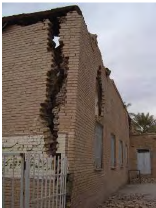
شکل (۴-۸-ب): جدا شدن دیوارهای بنایی از یکدیگر
