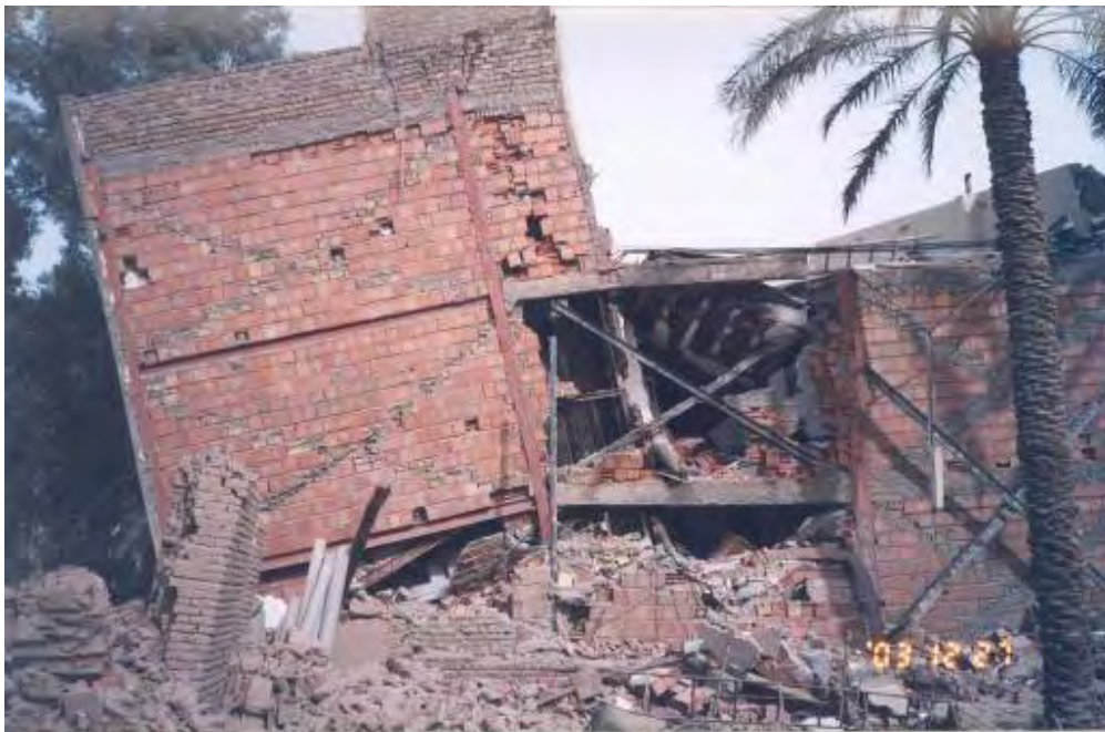
شکل (۴-۴۴-ب): خسارت شدید و فروریختگی در یک ساختمان ۵ طبقه فولادی نمای جنوبی
