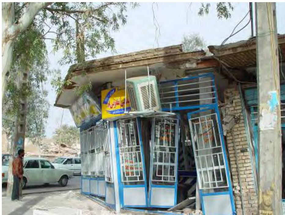
شکل (۴-۲۲-ب): تغییر شکل جانبی و کج شدگی در ساختمانهای مصالح بنایی نیمه اسکلت
