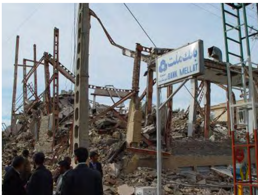
شکل (۴-۵۰): گسیختگی تیرهای لانه زنبوری و فروریختن سقف ها
