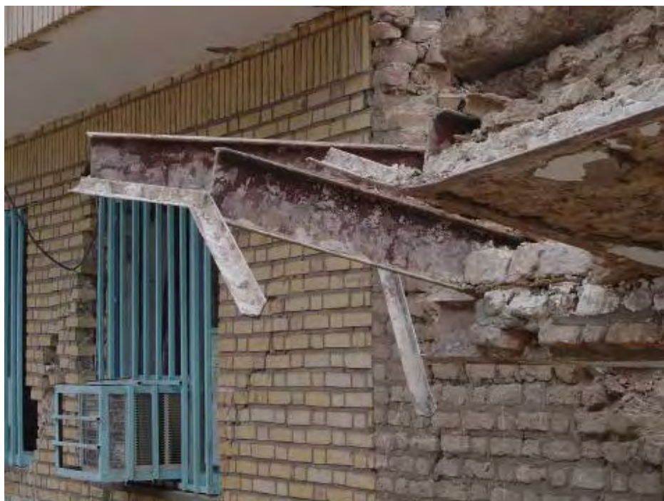
شکل (۴-۱۹-الف): اتصال تیرچه های سقف با نبشی در سقف یک ساختمان بنایی
