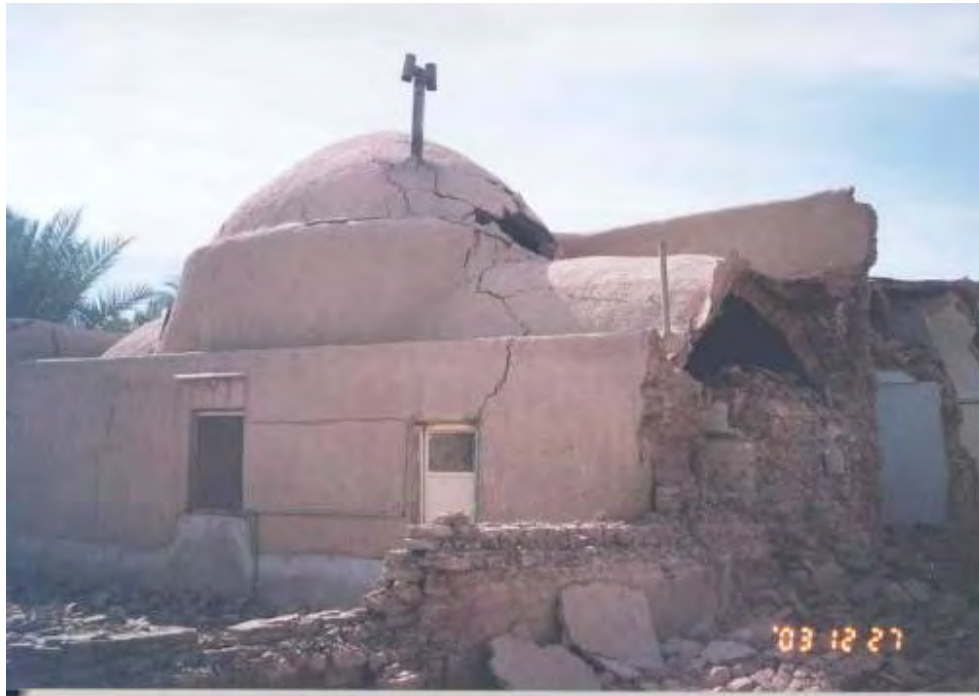
شکل (۳-۴): ترکهای مورب قطری کنار باز شو باربردر دیوارهای خشتی
