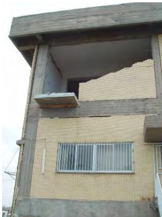
شکل (۴-۷۵): فرو ریختن خارج از صفحه میانقاب در یک ساختمان بتنی مسلح
