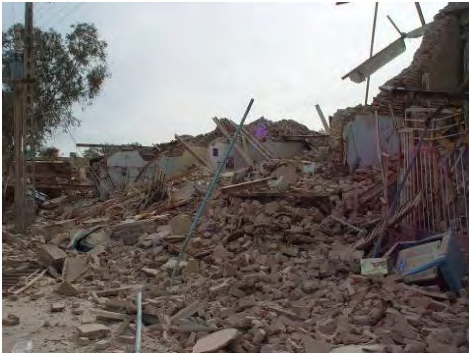
شکل (۴-۲۳-ب): فروریختگی کلی در ساختمانهای مصالح بنایی
