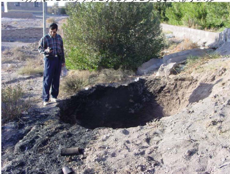
شکل ۲۳: فرونشست زمین در زیر یکی از راههای فرعی منطقه بروات در اثر ریزش لایه های فوقانی کوره ها و میل جاههای قنات در غرب بروات در اثر ارتعاشات ناشی از زلزله
