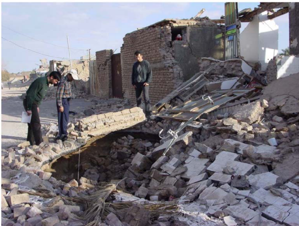
شکل ۲۵: فرونشست زمین در غرب منطقه بروات در اثر زلزله بم، این فروچاله منجر به تخریب بخشهایی از یک ساختمان مسکونی شده است.
