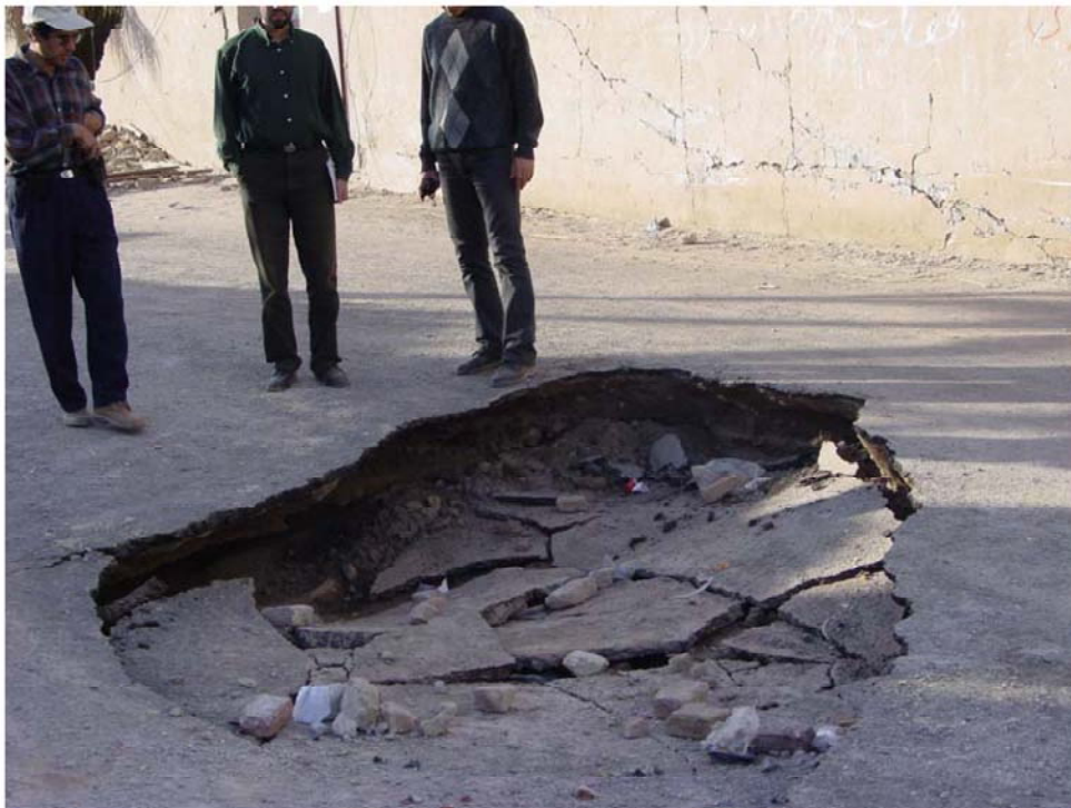
شکل ۲۳: فرونشست زمین در زیر یکی از راههای فرعی منطقه بروات در اثر ریزش لایه های فوقانی کوره ها و میل جاههای قنات در غرب بروات در اثر ارتعاشات ناشی از زلزله
