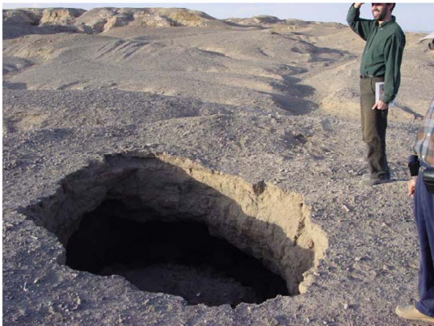
شکل ۱۹: فرونشست سطح زمین در اثر ریزش لایه های فوقانی به داخل کوره قنات در اثر ارتعاشات ناشی از زلزله بم در محدوده غرب پروات
