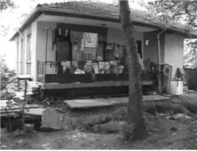
تصویر (۳): عبور خط گسل از زیر یک خانه مسکونی یک طبقه در منطقه روستایی تپه تارلا (Tepe Tarla) و آسیب دیدگی محدود
