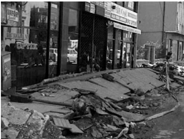
تصویر (۲۲، ب): شکست کلی ظرفیت باربری پی و بالا آمدگی خاک در سمت پیاده رو در شهر آداپازاری [۳]
