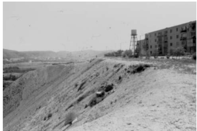
ب: احداث آپارتمان در کناره های دامنه های با احتمال لغزش
