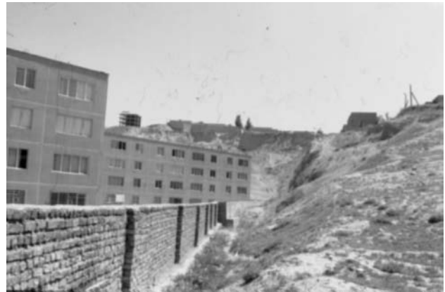
الف: مجتمع های مسکونی و آموزشی احداث شده در بخش باختری شهرک ولی عصر
