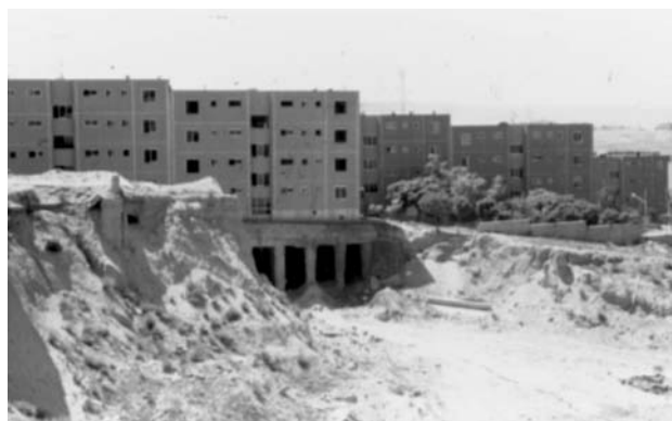
پ: پدیدار شدن شمع کوبی های انجام شده در زیر آپارتمانهای احداث شده
