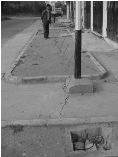
በ አዲስ አበባ የህንፃዎች ለተገንባቢው የህንፃዎች ጽንፈኛ ግንባታ ስራዎች
