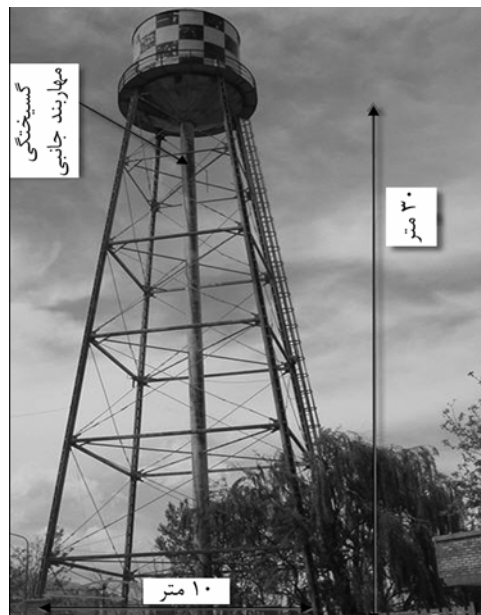
تصویر (۶): نمایی از مخزن هوایی کارخانه خمیرمایه.
