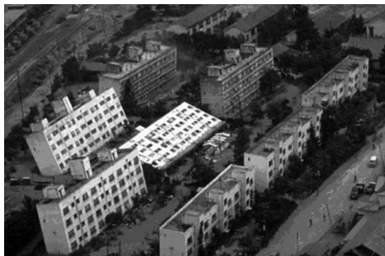
تصویر (۱): نشست و چرخش ساختمانها در زلزله نیگاتا ۱۹۶۴.
