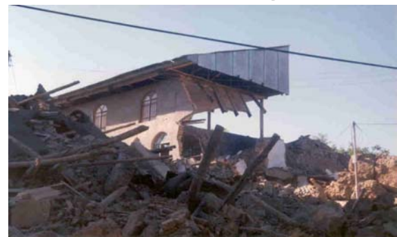
تصویر (۳۷): تخریب دیوار و ریزش سقفهای طاق ضربی ساختمان نیمه فلزی در چنگوره
