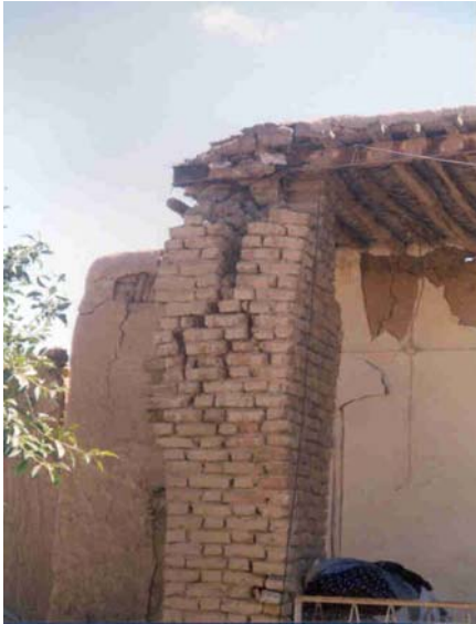
تصویر (۲۰): شکست پایه آجری از محل روی هم قرار گرفتن بندهای قائم آجرچینی در نجف آباد
