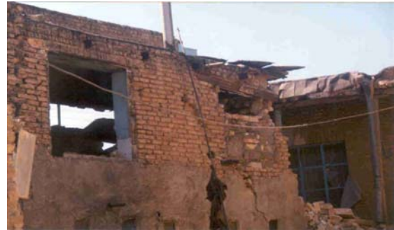
تصویر (۲۴): شکست در دیوار آجری در آوج، وجود نعل درگاه با تکیه گاه طولیل از ریزش سقف جلوگیری کرده است
