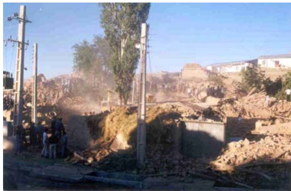
تصویر (۱): تخریب کامل خانه های خشتی در چنگوره
