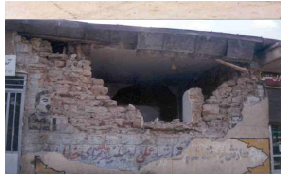
تصویر (۳): تخریب دیوار سنگی در آوج، ابعاد سنگها نامتناسب بوده و با ملات گل روی هم چیده شده اند
