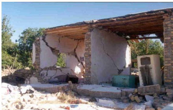
تصویر (۱۱): تخریب خارج از صفحه دیوارهای عمود بر راستای زلزله و شکست قطری در دیوارهای در راستای زلزله در چنگوره
