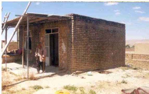
تصویر (۳۴): سالم ماندن خانه یک طبقه دارای شازه‌های افقی در آوج
