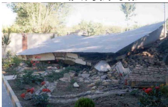
تصویر (۹): تخریب کامل دیوارهای آجری و ریزش سقف به طور کامل در چنگوره
