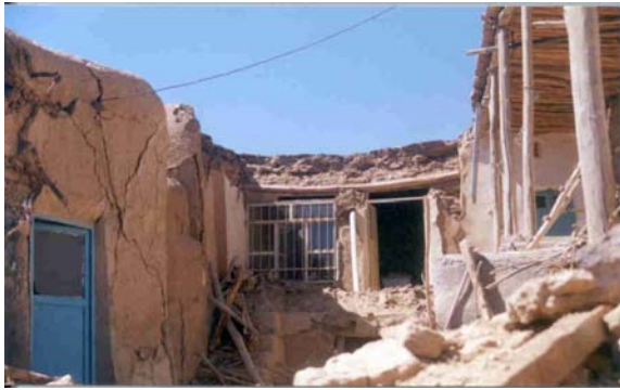
تصویر (۶): شکست در خانه خشتی با سقف به ضخامت بیش از ۵۰ سانتیمتر در آوج
