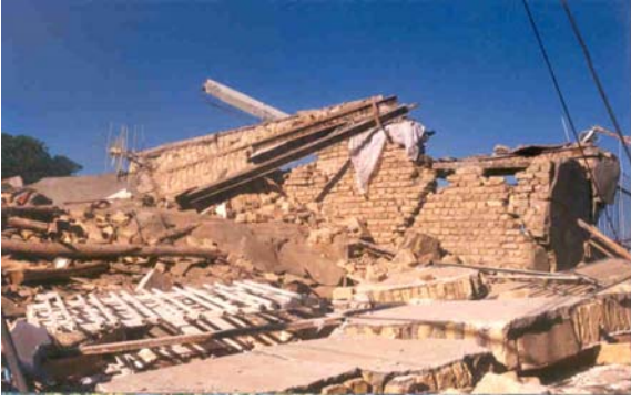
تصویر (۲۶): تخریب دیوارها و ریزش سقف طاق ضربی در چنگوره
