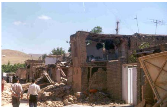
تصویر (۷): تخریب خانه های آجری غیر مسلح در آوج
