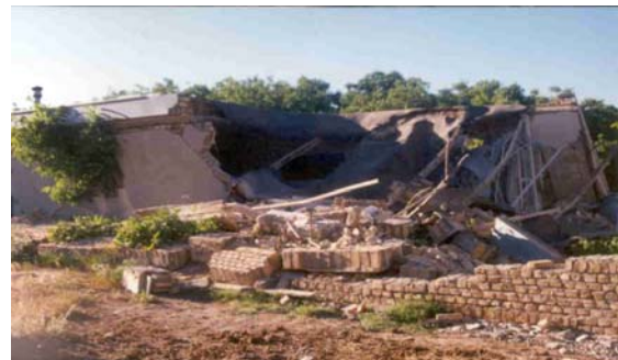
تصویر (۲۵): تخریب دیوارهای باربر و ریزش کامل قسمتی از سقف طاق ضربی در چنگوره، فاصله تیر آهنها بیش از ۱۲۰ سانتیمتر است
