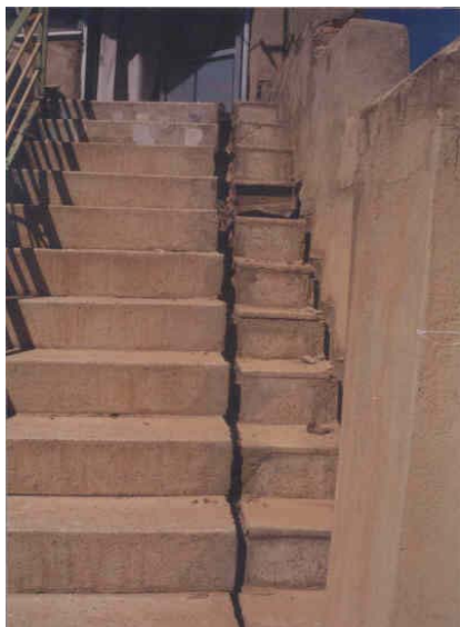
تصویر (۴۸): جدا شدگی در محل ناپیوستگی پله در آوج
