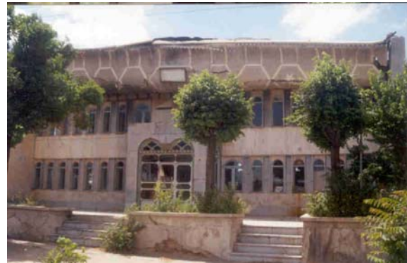
تصویر (۳۱): شکست در کنسول رستورانی در آوج به دلیل سنگینی و عدم مقاومت کافی در برابر مؤلفه قائم زلزله
