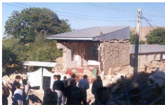
تصویر (۸): تخریب خارج از صفحه دیوار آجری به همراه قسمتی از دیوارهای عمود بر آن در چنگوره
