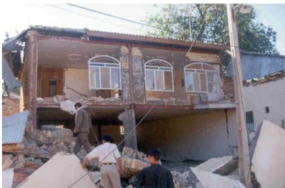
تصویر (۸): استفاده از کلافهای فلزی در نگهداری از دیوارهای غیرسازه ای و پنجره ها (روستای چنگوره)
