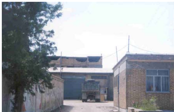
تصویر (۷): آسیب دیدگی دیوارهای غیر باربر (شهر آوج)
