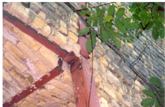
تصویر (۱۵): نمونه دیگری از اتصال تیر- ستون قوطی شکل با سوراخ کردن ستون (روستای چنگوره)
