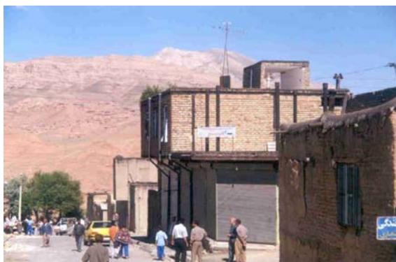
تصویر (۶): کنسول با دستک فلزی، بدون آسیب دیدگی (شهر آوج)، استفاده از کلافهای فلزی مشهود است
