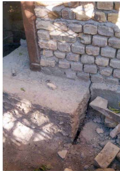
تصویر (۱۳): بلند شدگی پی و ستون از روی زمین (روستای چنگوره)
