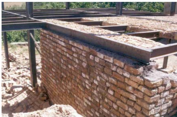
تصویر (۱۷): اجرای ترکیبی اسکلت فلزی- دیوار حمال (شهر آوج)
