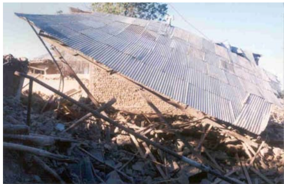
تصویر (۲۰، الف): اتصال اتکایی تیر روی ستون، (روستای چنگوره)
