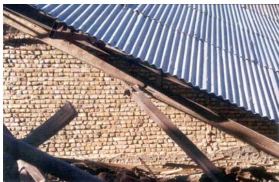
تصویر (۲۰، ب): جزئیات اتصال اتکایی تیر روی ستون
