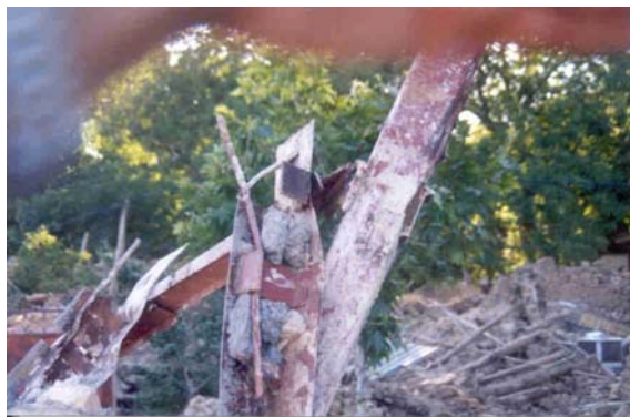
تصویر (۲۲): استفاده از پروفیل های سرد در و پنجره به عنوان تیر باربر سقف (روستای چنگوره)
