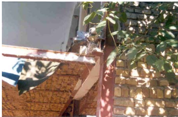
تصویر (۱۱): جدا شدن اتصال تیر به ستون (روستای چنگوره)
