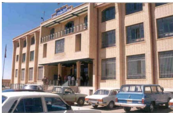
تصویر (۳): آموزشگاه امام علی شهر آوج، سیستم سقف مرکب و اسکلت فولادی
