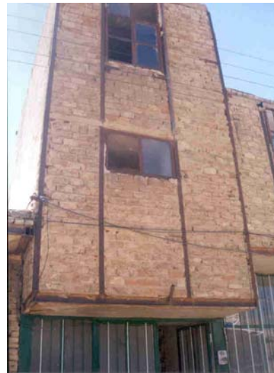
تصویر (۹): استفاده از کلافهای فلزی در نگهداری از دیوارهای غیرسازه ای و پنجره ها (شهر آوج)
