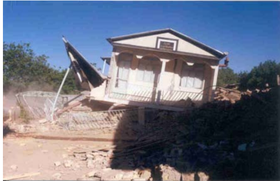
تصویر (۱۶، الف): ایجاد طبقه نرم در ساختمان دو طبقه فلزی (روستای چنگوره)
