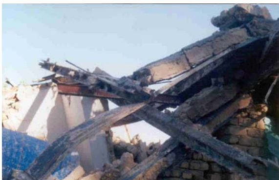
تصویر (۲۱): استفاده از پروفیل‌های سرد در و پنجره به عنوان تیر باربر سقف (روستای چنگوره)
