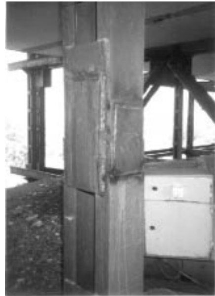
تصویر (۳): تقویت جوش ورق موجود و اضافه نمودن ورق جدید به جان ستون موجود به منظور تقویت اتصال
