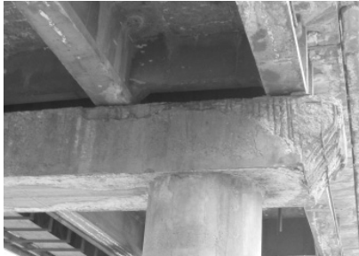
تصویر (۳): خرابی رایج عرشه ساده و عدم تعبیه برشگیر عرضی در کنار تیرهای اصلی و کم بودن عرض سرتیر و نشیمنگاه شاهتیرها
