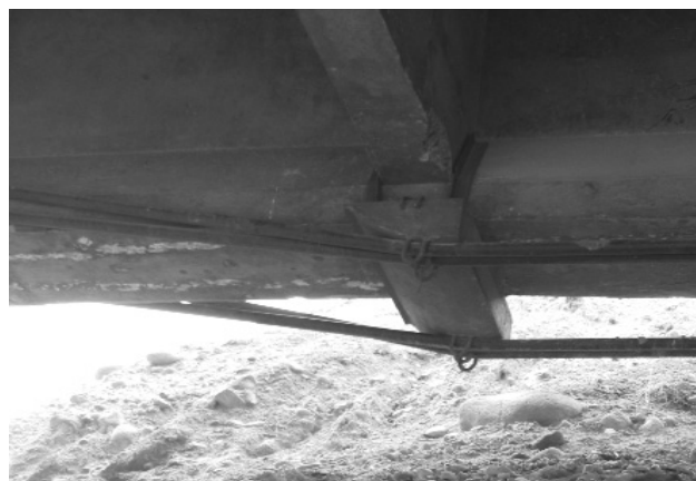
تصویر (۵): کابل‌های تقویت که به صورت خارجی و از دو طرف تیرهای طولی رد شده‌اند.
