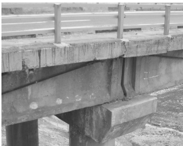
تصویر (۷): نشست تیرهای اصلی بر روی سر تیرها بدون واسطه
