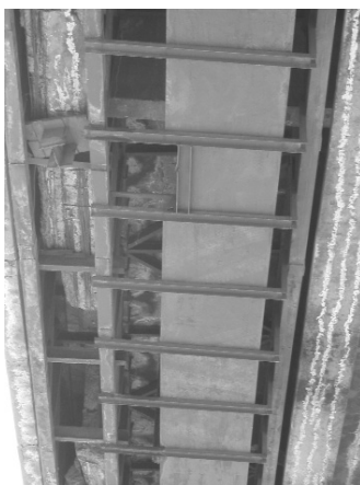
تصویر (۴): قسمت افتاده تیر اصلی و جانشین‌سازی آن با خرپای فلزی (تصاویر) خرپاهای جایگزین را از زیر و پهلو نشان می‌دهند.
