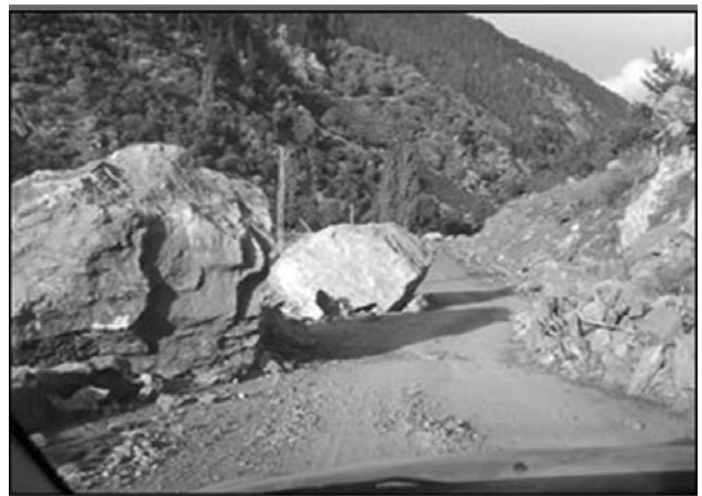
تصویر (۸): سقوط بلوک‌های سنگی در نزدیکی مظفرآباد بر اثر رخداد زمین‌لرزه ۸۴/۷/۱۶
