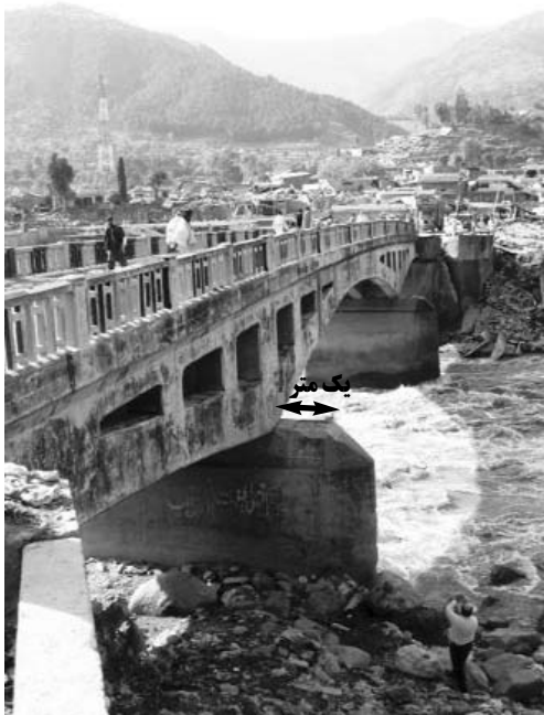
تصویر (۱۵، الف): پل بتنی بالاکوت که بر اثر زمین‌لرزه ۸۴/۷/۱۶ به میزان بیش از یک متر در راستای گسل جابه‌جا شده است.
