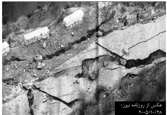
تصویر (۱۱): تخریب جاده در نزدیکی بالاکوت بر اثر ایجاد ترک‌های کششی سطحی در زمین لرزه ۸۴/۶/۱۷ بالاکوت پاکستان [۸]
