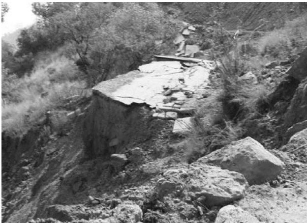
تصویر (۱۰): تخریب جاده اسلام‌آباد- مظفرآباد بر اثر رخداد زمین‌لرزه ۸۴/۷/۱۶ بالاکوت
