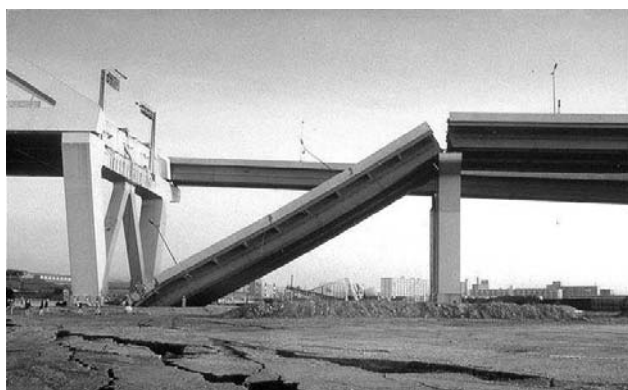
تصویر (۱): پل نیشینومیاکو در زلزله ۱۹۹۵ کوبه ژاپن
