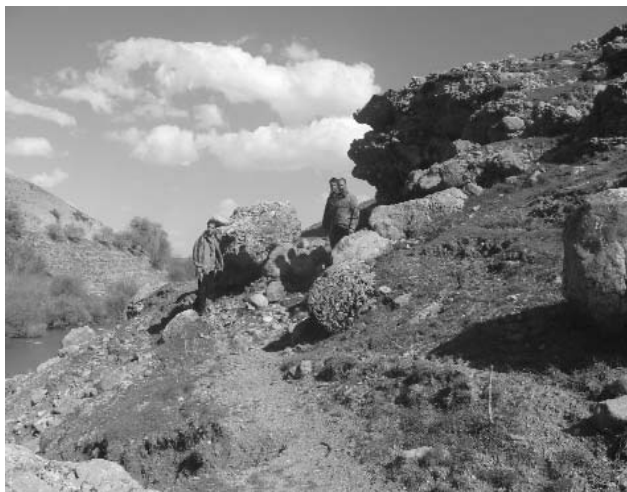
تصویر (۸): ریزش ایجاد شده بر اثر زلزله (روستای تنگ محمد حاجی بالا)
