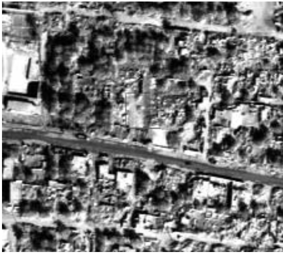
ب: بعد از وقوع زلزله
