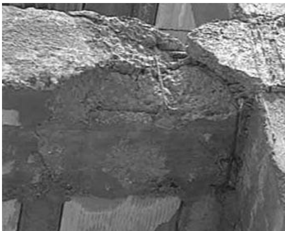
تصویر (۴): ترک‌های برشی یا خرد شدگی بتن پوشش تیرها در محل اتصال به ستونها
