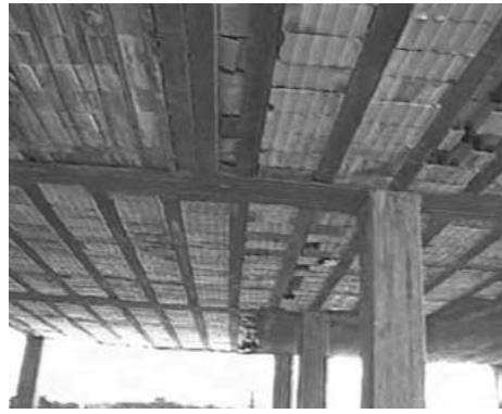
تصویر (۵): استفاده از تیرچه به جای تیر در قابهای خمشی
