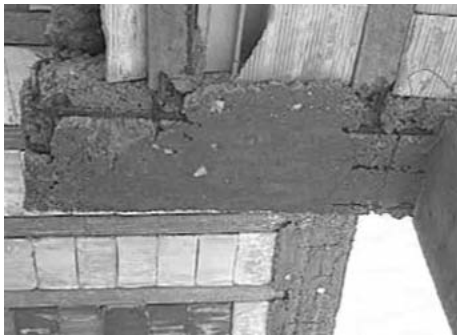
تصویر (۷): کمبود پوشش بتنی و فقدان خم انتهایی در میلگردهای اصلی تیر که بیرون از محل اتصال به ستون قرار دارند.
