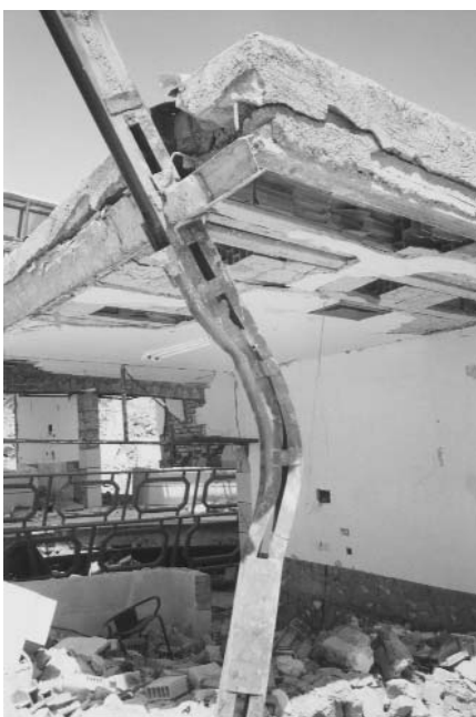
تصویر (۱): کمانش کلی ستون حول محور عمود بر قیدها
